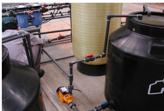
Foto 2. 7. Instalación de sistemas de retrolavado de filtro y lavado de membranas de OI.
