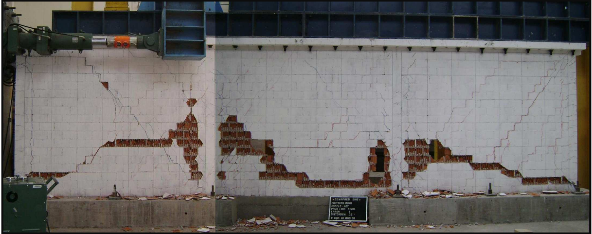
Figura 3.11. Estado final del muro ME7
