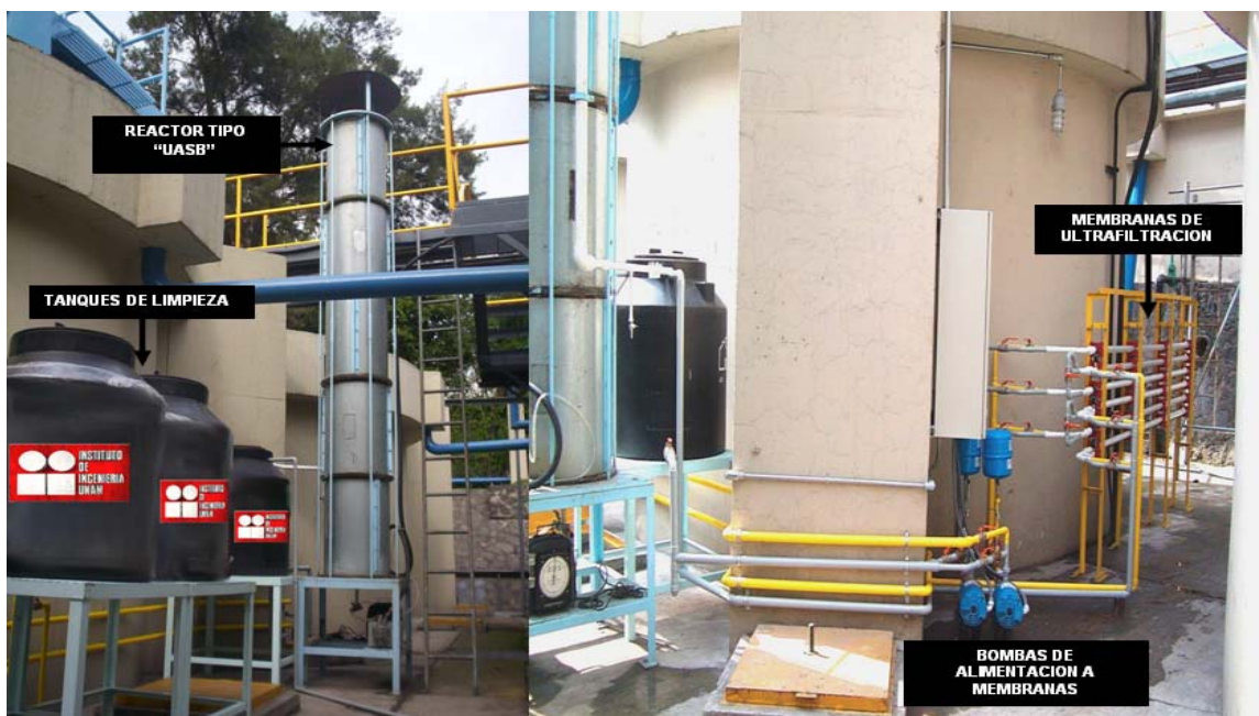
Figura 4.3 Arreglo general del sistema UASB- membranas (Cid, 2007)
