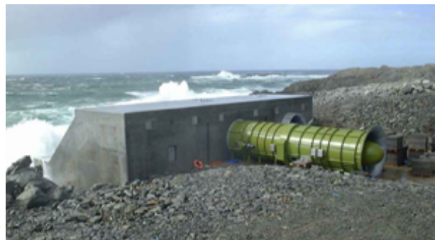
(b) Montaje de turbo-maquinaria
