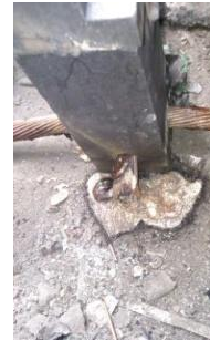
Imagen 70. Molde con el cable a soldar y la soldadura en estado líquido derramada.
