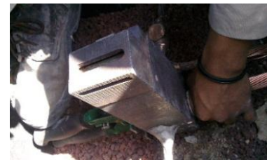
Imagen 26. Molde de grafito, se notan los cables que entran junto con una macilla que evita que se derrame la soldadura y a la izquierda las pinzas de sujeción.
