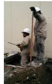
Imagen 18. Se desea perforar la pared de fondo donde se ubican los interruptores a aterrizar.
