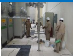
Imagen 67. Cuarto de interruptores, siendo limpiado al finalizar los trabajos.
