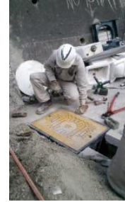
Imagen 30. Nivelando el registro con base en el suelo de alrededor.
