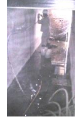
Imagen 46. Fijando el cable de tierra a la pared de una trinchera inundada por las lluvias.
