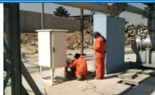
Imagen 75. Instalación de nuevos equipos no contemplados en el proyecto original pero que deben ser aterrizados.
