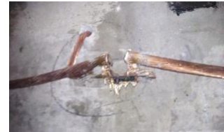
Imagen 72. Las altas temperaturas derritieron el cable y todo el material se derramó. Pueden verse las rebabas que escurrieron por el interior del molde.
