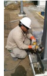
Imagen 50. Limando los bordes afilados o rebabas de la soldadura para seguridad y mejor presentación.
