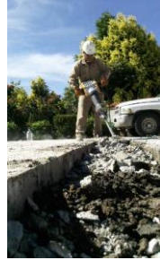
Imagen 5. Rompiendo el concreto con ayuda de un martillo eléctrico, se hace un camino para enterrar un anillo de cable nuevo.
