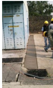
Imagen 65. Trabajos finalizados y zona de trabajo limpia.
