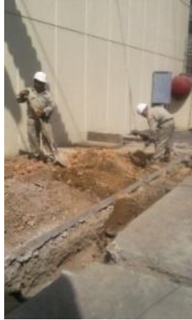
Fotografía 12. Relleno de zanja que aloja el cable del anillo de tierra.
