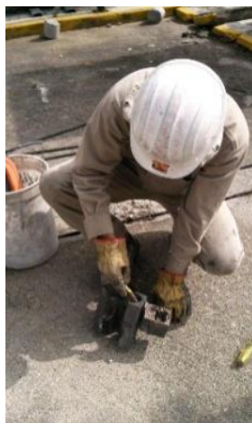
Fotografía 9. Molde para soldar, se pueden ver la tapa y las cámaras interiores.
