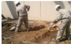
Imagen 59. Con ayuda de una pala se rellena la zanja, posteriormente con una escoba se barre hacia la misma zanja toda la tierra restante.
