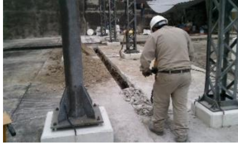
Fotografía 1. Rompimiento del concreto con ayuda de un rotomartillo eléctrico.
