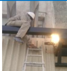
Imagen 39. Aterrizamiento de una estructura aérea de la subestación. Por seguridad es indispensable el uso de equipo de protección.
