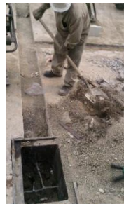
Imagen 57. Rellenando la zanja y la periferia de un registro de electrodo de tierra.
