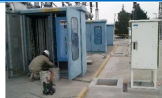
Imagen 56. Aplicando una de las capas de pintura a la zapata que aterriza la barra de tierra del gabinete que controla un interruptor.
