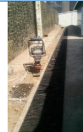
Imagen 58. Herramienta que sirve para apisonar la tierra. Si la tierra no es apisonada se corre el riesgo de que el concreto se cuarte por hundimiento.
