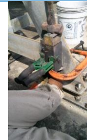
Imagen 38. Molde presionado fuertemente a la estructura, el cable a soldar se introduce en la parte inferior.
