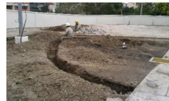
Imagen 12. Parte de una zanja destinada a albergar el anillo de tierra que rodeará la subestación eléctrica.
