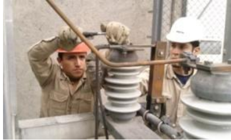
Fotografía 10. En áreas donde no se puede soldar directamente, es imprescindible el uso de zapatas.
