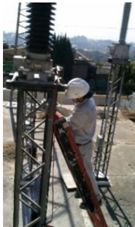
Fotografía 7. Instalación de zapata para aterrizar la base de un apartarrayo.
