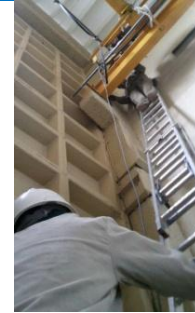
Imagen 54. Aplicando la primera capa, enseguida debe pintarse cada una de las soldaduras de su respectivo color de manera que se mimeticen.
