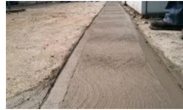
Imagen 62. El concreto nuevo debe nivelarse con respecto al piso de alrededor y de preferencia peinarlo con la escoba para darle una mejor presentación.
