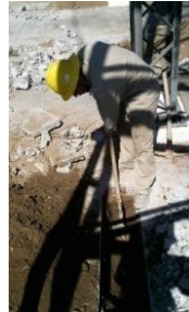
Imagen 9. Buscando el cruce de la malla de tierra.
