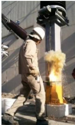
Fotografía 8. Soldando el cable de tierra directamente a la estructura.
