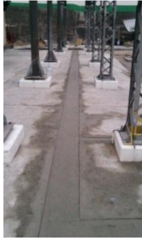
Fotografía 14. Área de trabajo limpia al finalizar las labores.
