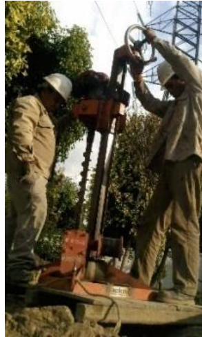
Fotografía 3. Perforación para alojar electrodo de tierra.
