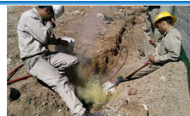
Imagen 28. Instante de la ignición de la pólvora que derrite la soldadura para unir los cables.
