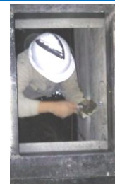
Imagen 48. Colocando la pija que sujetará la abrazadera y el cable de cobre.
