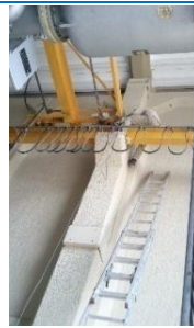
Imagen 37. Uniendo el soporte de una grúa aérea a la malla de tierra.
