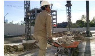
Imagen 8. El cascajo debe acumularse en una zona de fácil acceso para que el camión recolector lo pueda retirar con facilidad.
