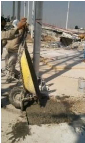
Fotografía 13. Reposición del concreto.
