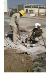
Imagen 6. Con ayuda de pico, pala y cizallas se retira el concreto de un recuadro donde debe localizarse un cruce de la malla, en caso de no encontrar el cruce se excava un recuadro adyacente.
