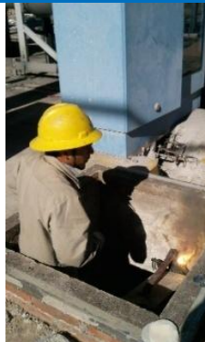
Imagen 25. Abajo a la derecha se ve la llama que sale del molde al unir el cable de cobre.
