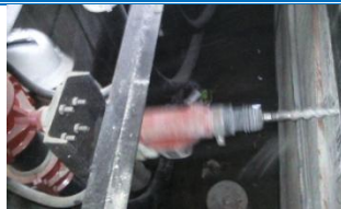
Imagen 19. Se necesita llegar hasta donde están unos cables a la derecha, es imprescindible realizar la perforación.
