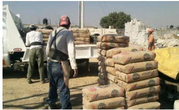
Imagen 21. Descarga de bultos de cemento para reponer el concreto.
