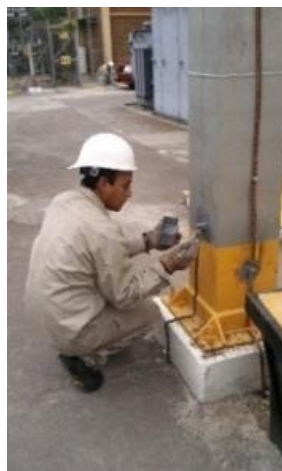
Fotografía 11. Pintura aplicada a la unión del cable y la estructura.
