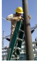
Imagen 45. Con ayuda de un taladro se perfora y fija la uña que abrazará al cable de cobre.
