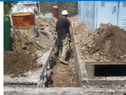
Imagen 11. Zanja que alojará el anillo de tierra que protegerá los interruptores ubicados dentro de los gabinetes azules (a la derecha).
