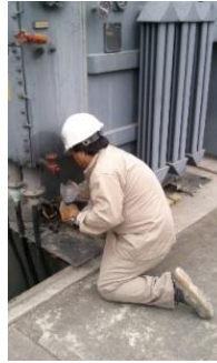
Imagen 53. Pintando las uniones en la base de un pequeño transformador de servicios propios.
