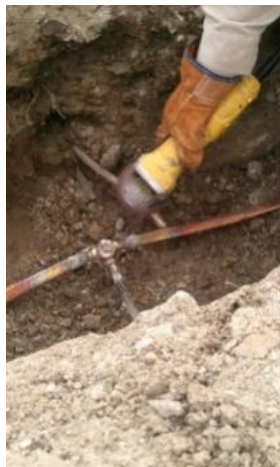
Fotografía 5. Unión de todos los cruces de la malla.
