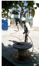
Imagen 33. Se puede ver el carrete casi vacío pues, la mayoría del cable ha sido instalado.
