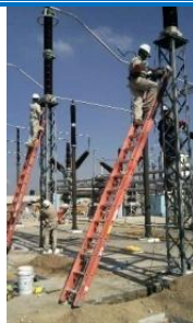
Imagen 41. Aterrizando con zapata la base del apartarrayo. Se puede apreciar el apartarrayo, abajo su estructura y arriba el conductor energizado de 230 [kV].
