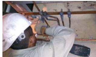
Imagen 55. Protegiendo las zapatas de la barra de tierra de unos interruptores.
