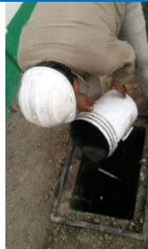
Imagen 31. Vaciando la solución electrolítica para rellenar los espacios entre el electrodo y la tierra circundante.
