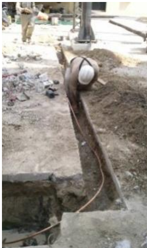
Fotografía 2. Tendido de cable de cobre nuevo.
