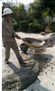
Imagen 63. Con ayuda de pala y carretilla la mezcla es llevada hasta donde se necesita.
