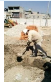
Imagen 10. Amplia excavación donde aún no se encuentra rastro del cable de la malla de tierra. Se debe continuar buscando.
