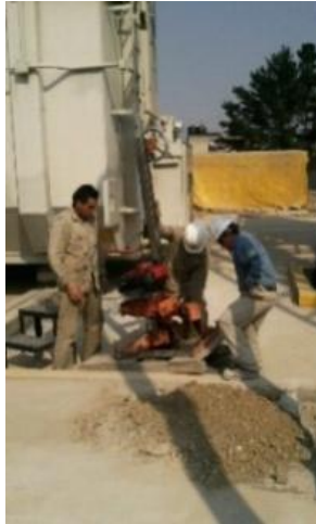
Fotografía 4. Instalación del electrodo cerca del transformador a proteger.
