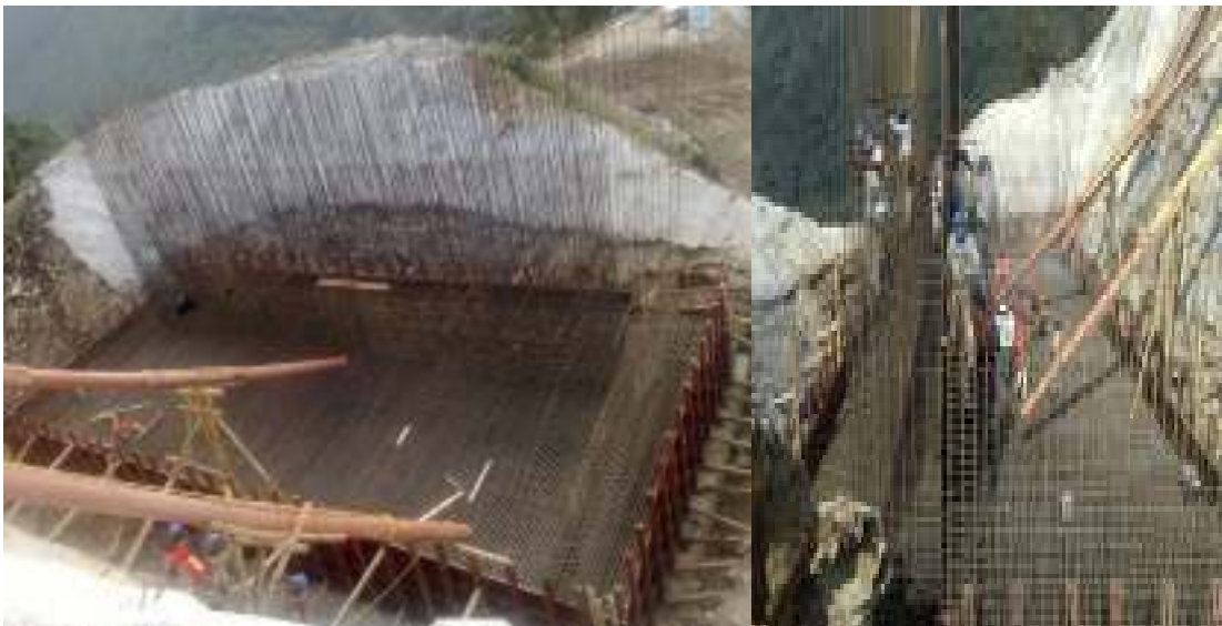
FIGURA 6 ZAPATA DEL ESTRIBO #1 DEL PUENTE “SAN MARCOS”
