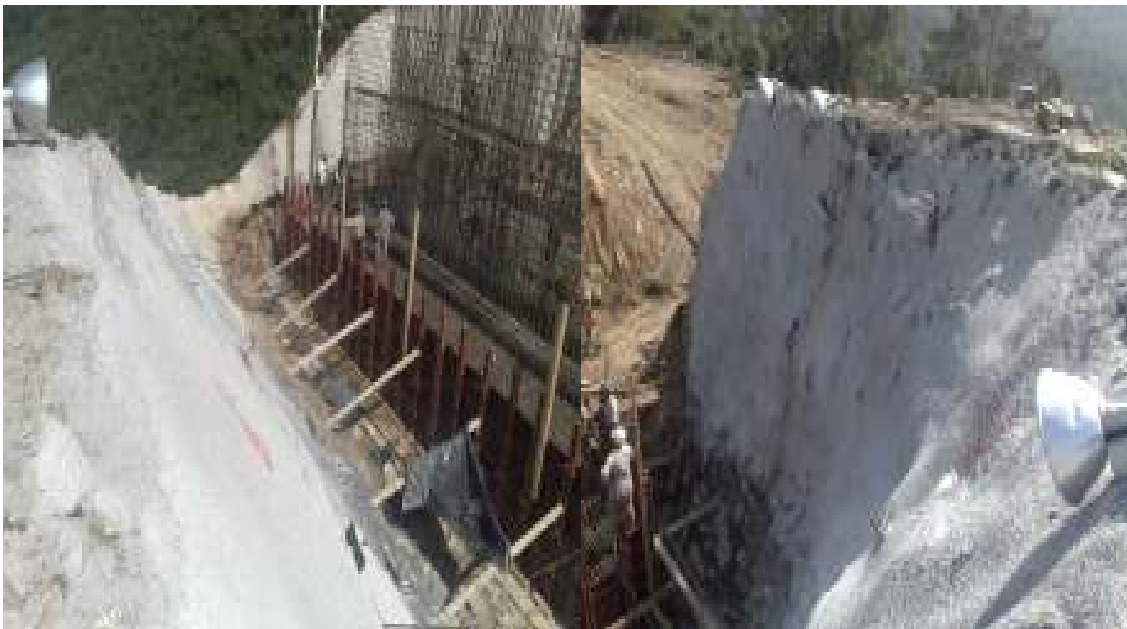
FIGURA 16 CONCRETO LANZADO EN TALUDES
