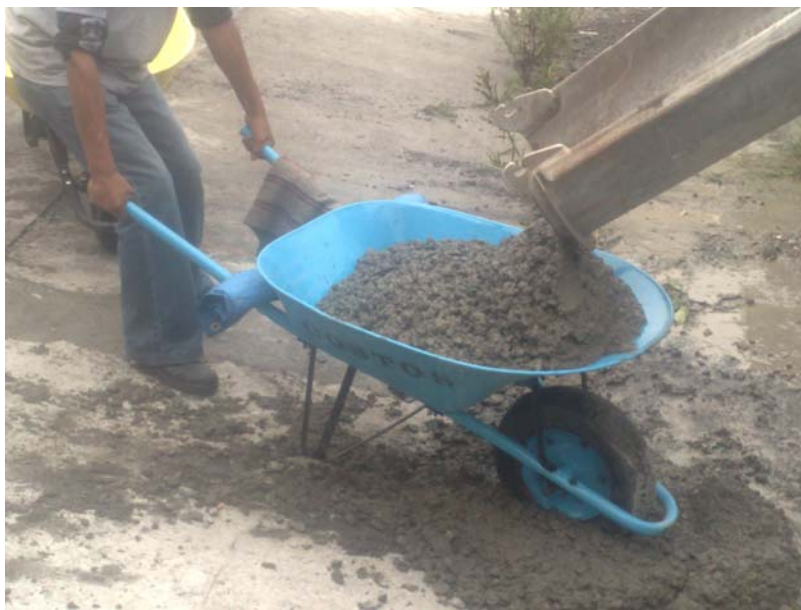
FIGURA 22 TOMA DE MUESTRA DE CONCRETO FRESCO
