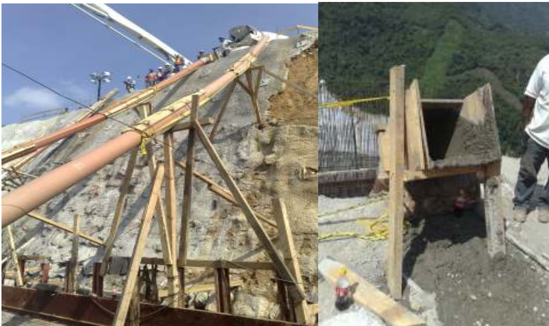
FIGURA 14 TUBERÍA DE PVC PARA VACIADO DE CONCRETO
