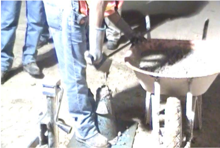
FIGURA 28 EXCEDENTE DE CONCRETO PARA GARANTIZAR EL NIVEL
