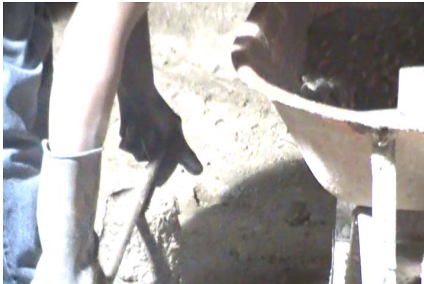
FIGURA 29 ENRASADO DE CONCRETO - RODAMIENTO DE VARILLA
