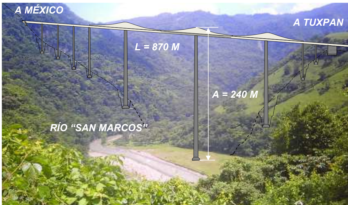
FIGURA 5 PUENTE "SAN MARCOS"
