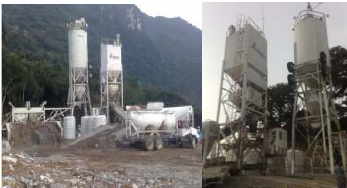
FIGURA 13 PLANTA CEMEX, LAS PILAS, PUE.
