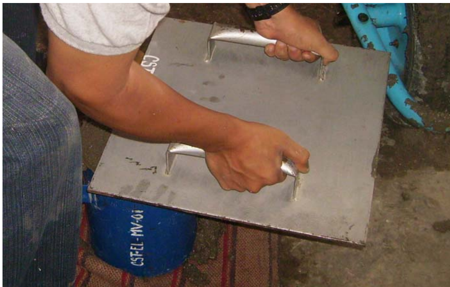
FIGURA 85 ENRASE CON PLACA METÁLICA - 2
