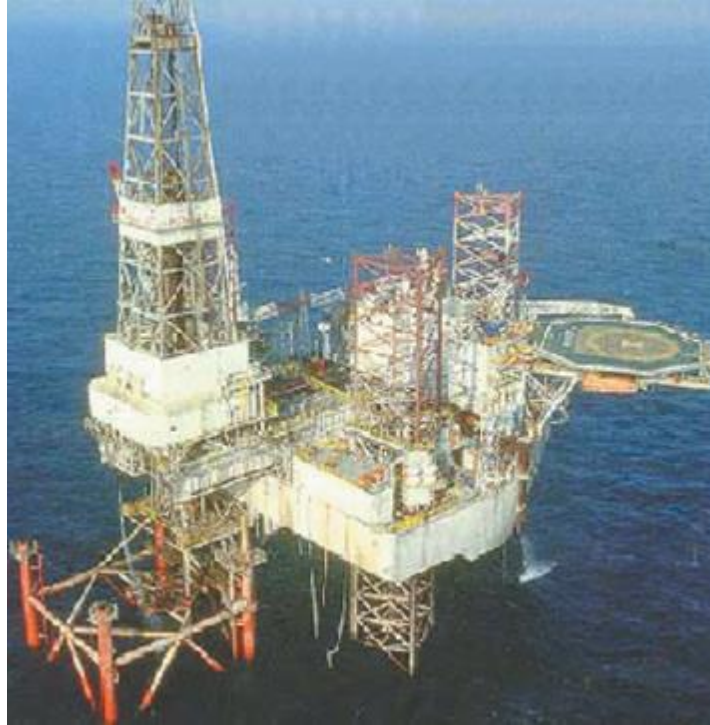
Figura 3.14. Tetrápodo con plataforma autoelevable.
