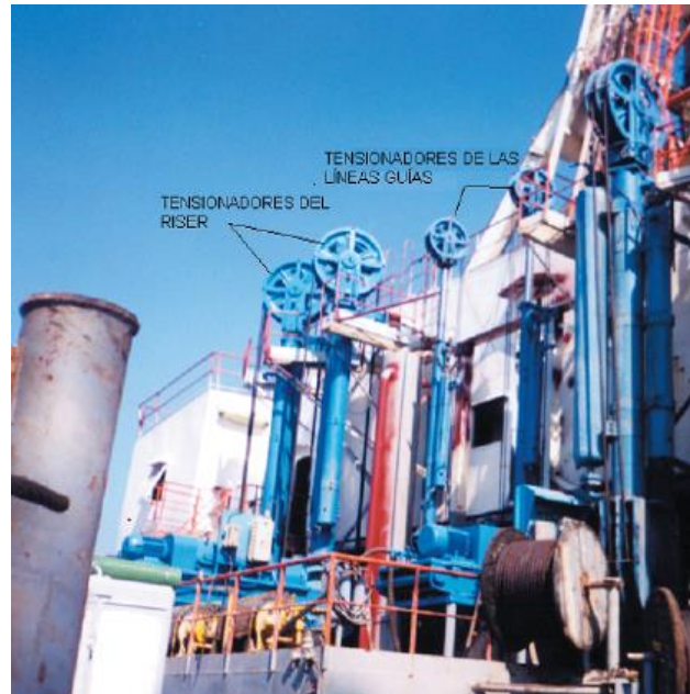
Figura 3.18. Tensionadores de líneas guías
