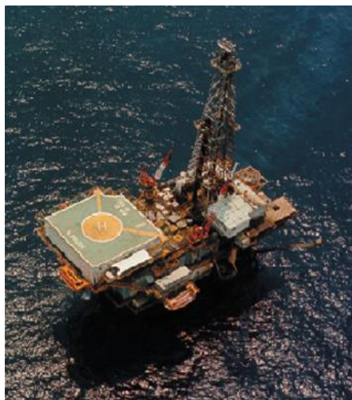
Figura 3.12. Plataforma fija de perforación.
