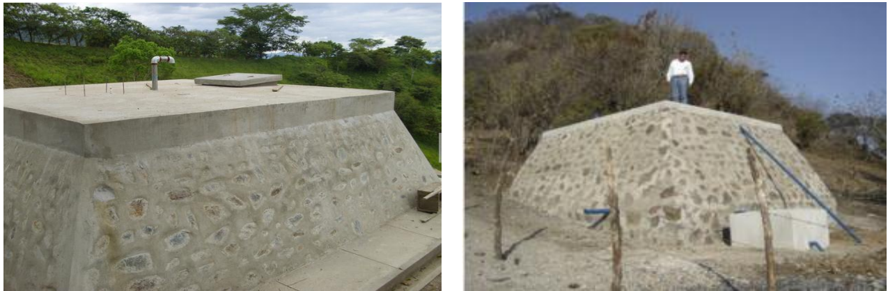
Figura 5.3 – Tanques de Mampostería.
