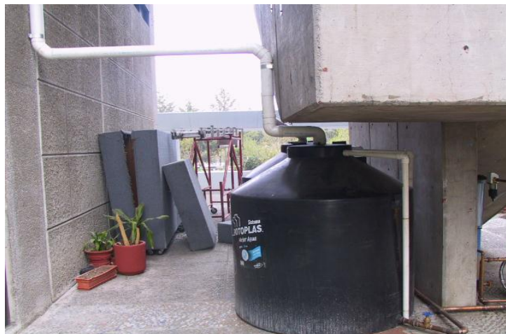
Figura 5.1 - Recomendación para la localización del tanque receptor del agua pluvial (o algo parecido)
