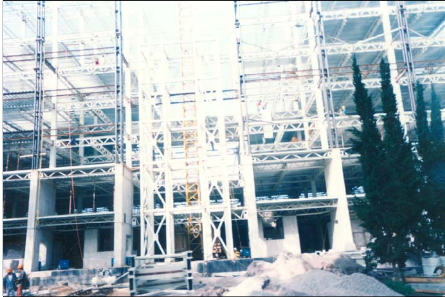
Imagen 13. Montaje de Estructura Metálica.
