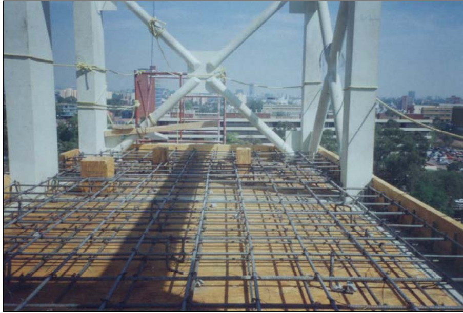
Imagen 15. Armado de losa en Cuarto de Máquinas.
