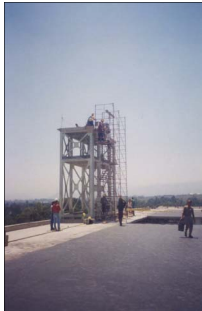
Imagen 16. Colado de losa en Azotea.
