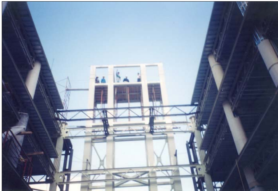
Imagen 14. Cubo de Elevadores. Estructura independiente al edificio.
