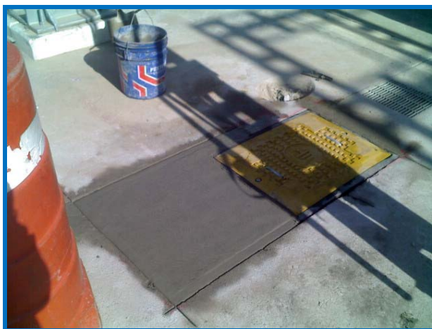
Figs. 28 y 29 Instalación de registros
