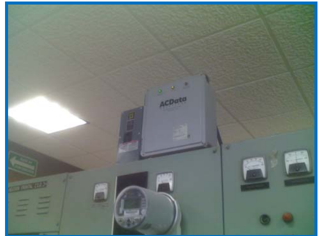
Fig. 25 Instalación de TVSS
