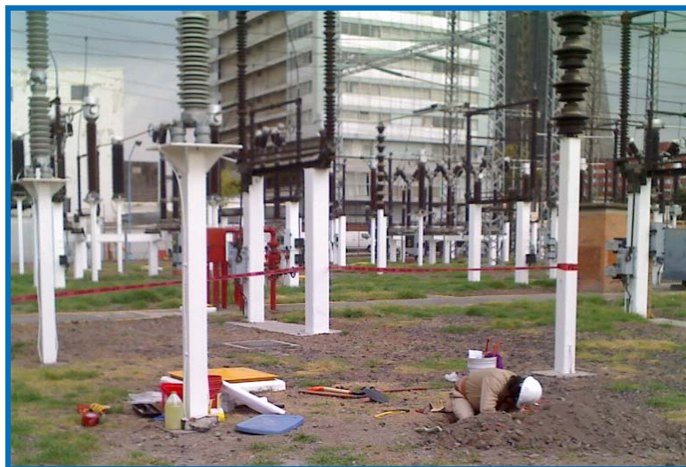
Fig. 16 Excavación de zanjas
