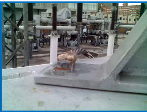
Figs. 20 y 21 Puesta a tierra de equipos y estructuras
