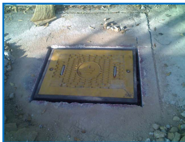
Figs. 28 y 29 Instalación de registros
