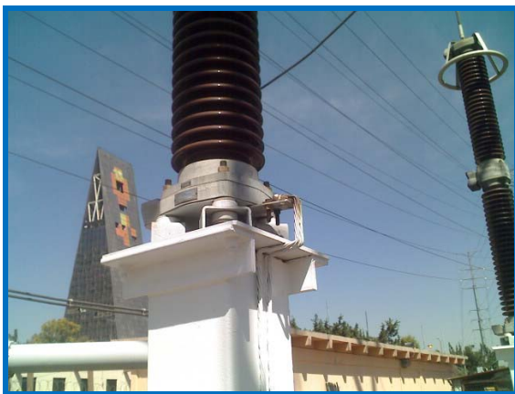
Figs. 22 y 23 Puesta a tierra de equipos y estructuras
