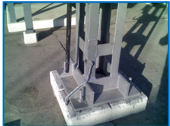
Figs. 22 y 23 Puesta a tierra de equipos y estructuras
