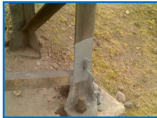
Figs. 20 y 21 Puesta a tierra de equipos y estructuras
