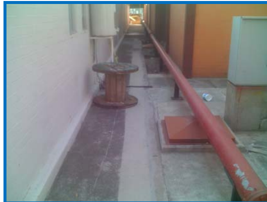
Figs. 26 y 27 Instalación de anillo de tierra
