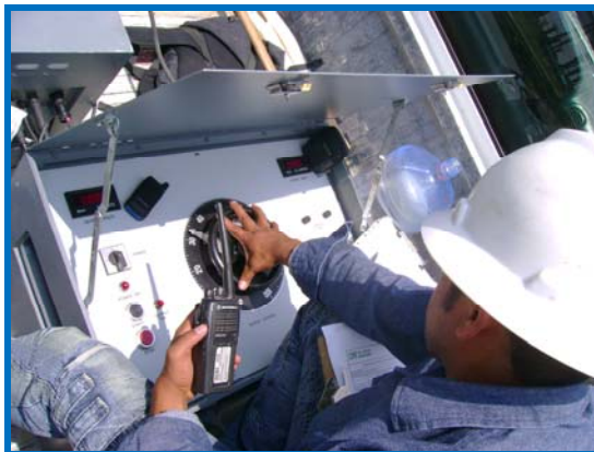
Fig. 14 Integridad física de la malla.
