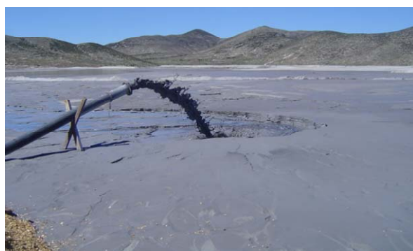
Figura 2.6 Fotografías de las dos presas de jales de la Unidad Minera Charcas
