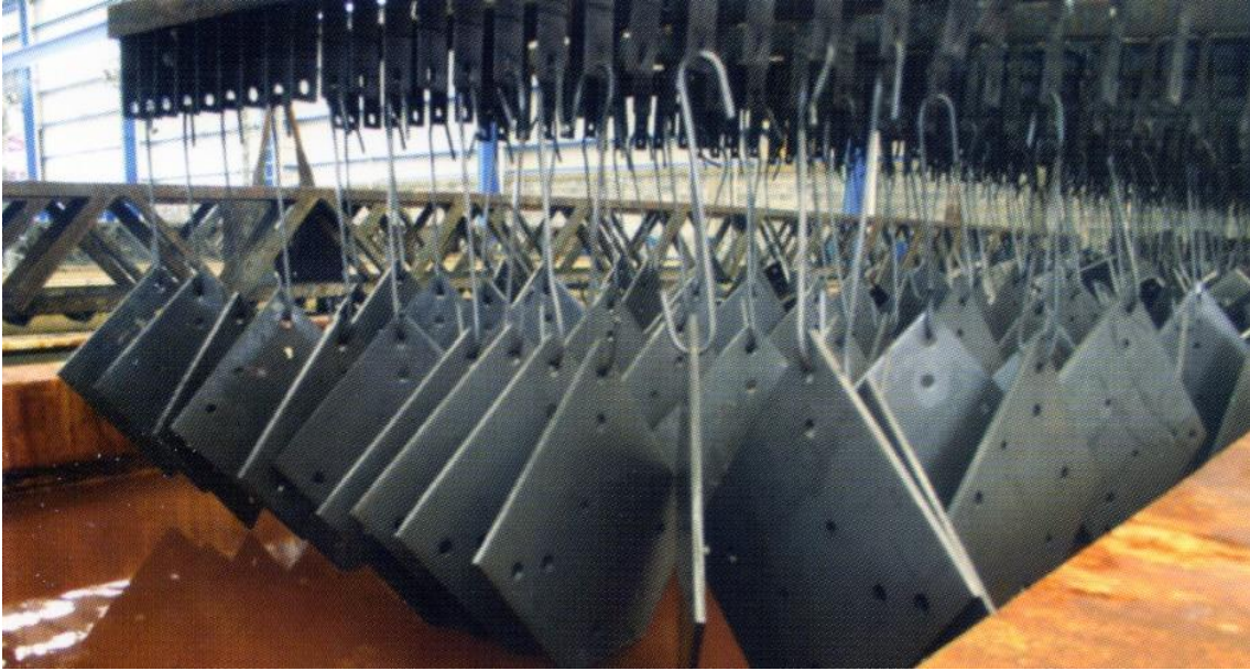
Figura (1.9.1.1) Preparación de la superficie del acero a galvanizar. Fuente Galvaqro S.A. de C. V.
