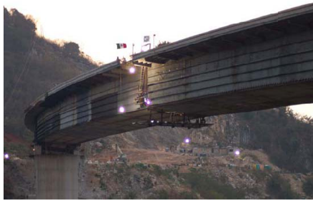
Figura 5.1 Puente San Cristóbal
