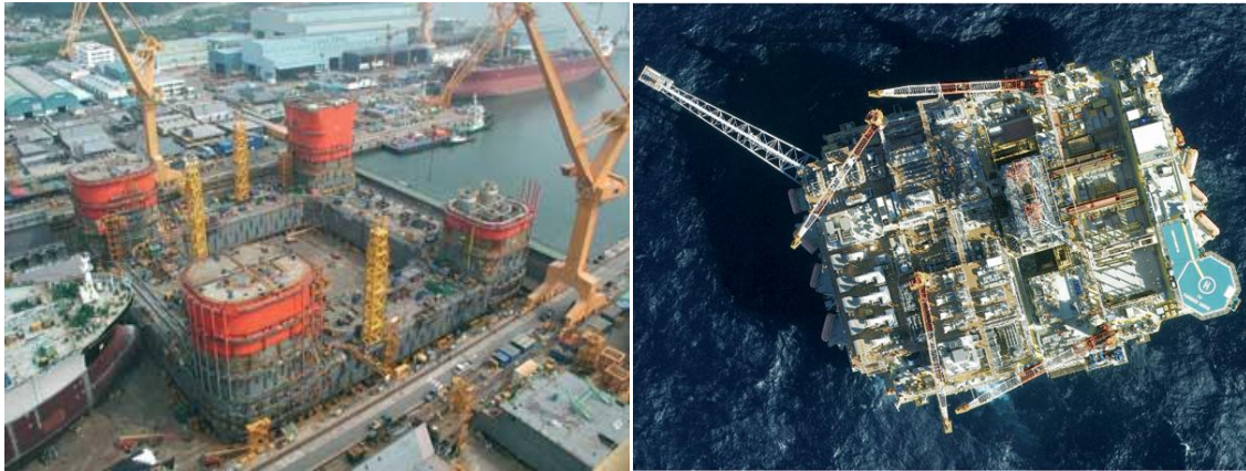
Figura 19. Construcción de la plataforma (izquierda) y vista superior de la misma
