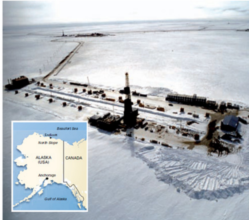
Fig. 4.2. Instalaciones de producción en el Campo Endicott, donde las pruebas interpozo han demostrado la efectividad de la tecnología LoSal® a escala de campo. En el pequeño recuadro a la izquierda se puede observar la localización de Endicott en la costa de la Pendiente Norte (North Slope) de Alaska. ( British Petroleum, 2009 )
