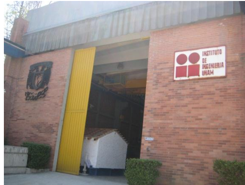
b) Fachada norte del laboratorio
