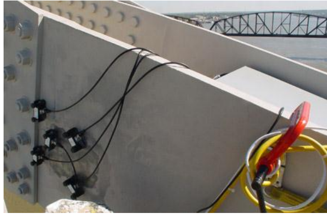
Figura 2.1. Viga instrumentada con transductores para la detección de sonidos ultrasónicos ( www.iti.northwestern.edu )
