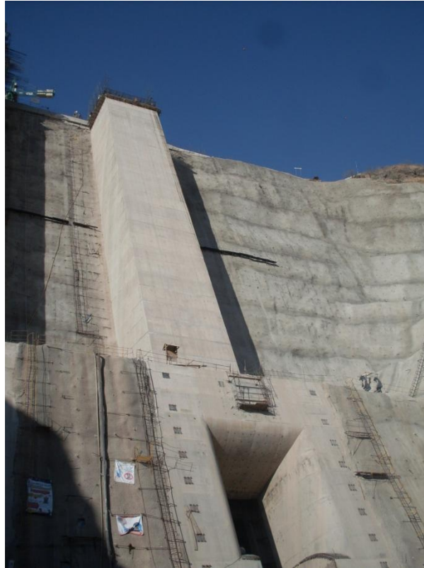
Figura 1.17 Se aprecia una de las dos obras de toma que fueron construidas en el C. H. La Yesca. En la foto están todavía en proceso de construcción. (Fuente Propia)
