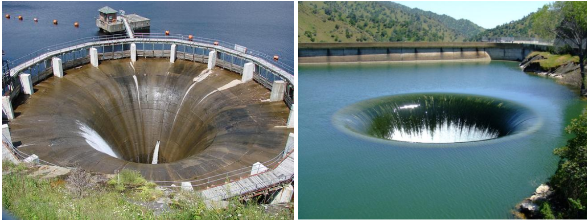
Figura 1.26 Vertedor de embudo de la presa Monticello en California, conocido también como “Glory Hole”. (Murillo, 2012)
