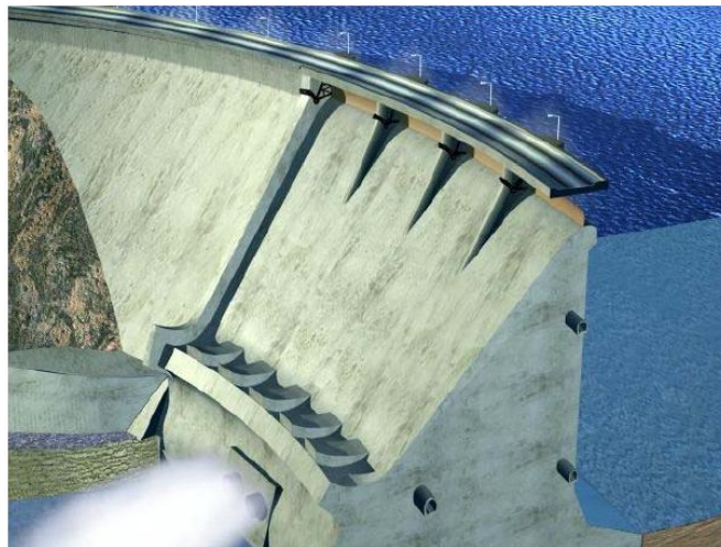
Figura 1.8 Presa de curvatura horizontal o Arco-gravedad. (Villarino, 2006)
