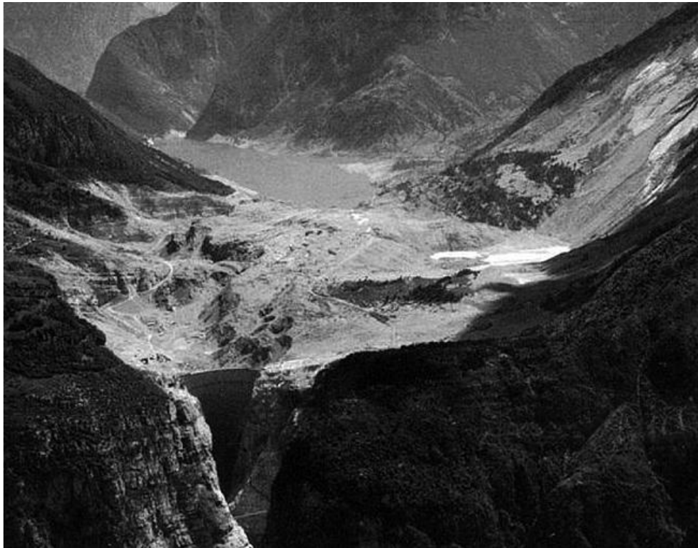
Figura 2.8 La presa Vajont después del deslizamiento
