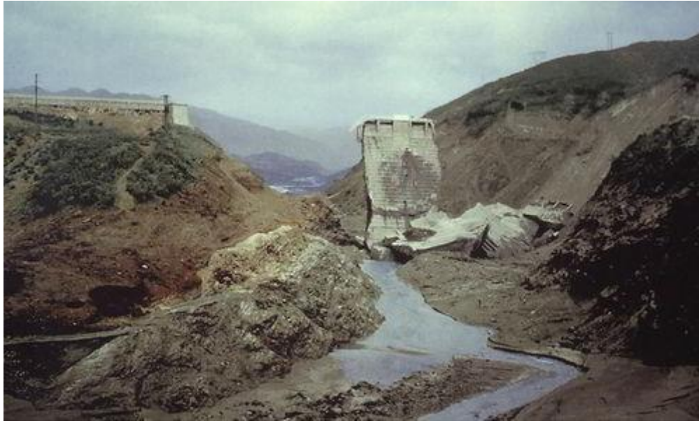
Figura 1.42 Falla en la cortina de la presa de St. Francis. Imagen obtenida de http://chillopedia.com/interesting/top-15-worst-dam-disasters-ever/
