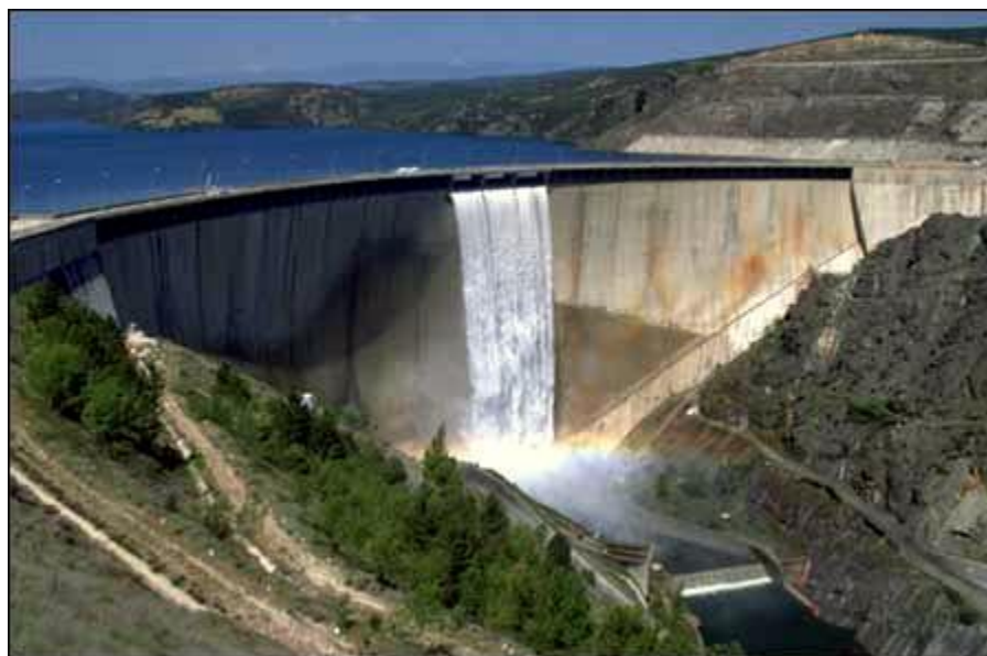
Figura 1.24 Presa El Atazar de doble curvatura. Ubicada en España. En la imagen se puede apreciar la operación de la obra de excedencia. (Murillo, 2012)
