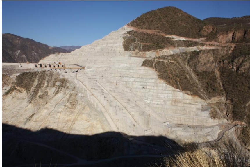
Figura 1.18 Obra de Excedencia de la C. H. La yesca. La característica de este vertedor contiene tres canales y al final de cada cana se puede apreciar la estructura terminal de salto de esquí. (Fuente Propia)
