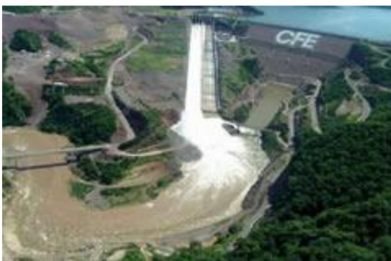
Figura 1.29 Vertedor en canal de la presa El Cajón, ubicada en el Estado de Nayarit.
