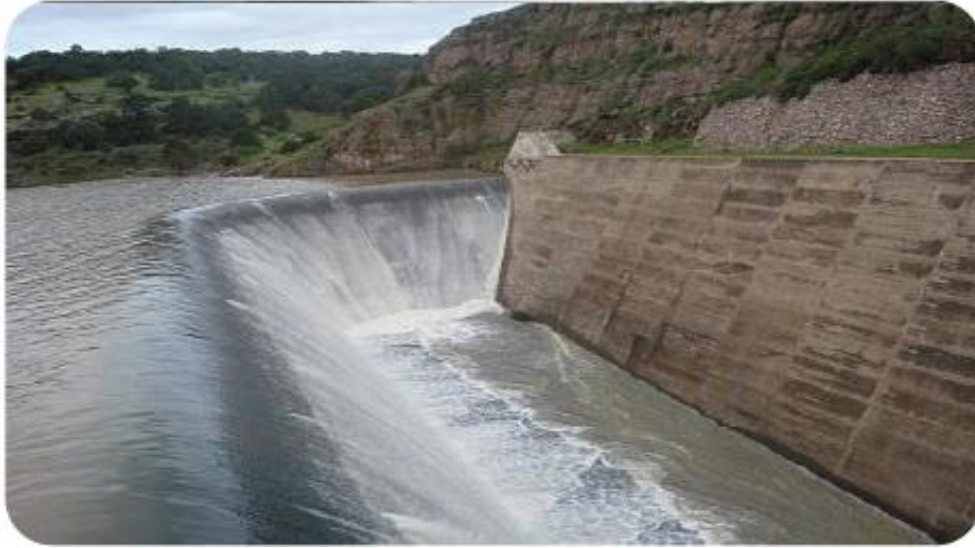
Figura 1.31 Canal Colector de un vertedor de canal lateral; vista hacia aguas arriba de la presa.
