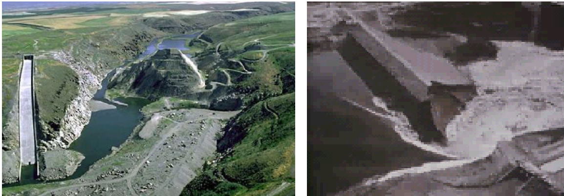
Figura 1.40 Falla en la presa Teton en la imagen de la derecha se aprecia el momento de la falla. http://fluidos.eia.edu.co/presas/tipos_presa/marcos/presa%20de%20terraplen/m_Teton_terraplen.htm
