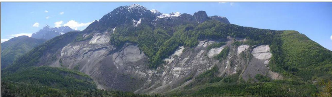
Figura 3.1 Superficie de falla del deslizamiento de 1963 de la presa Vajont
