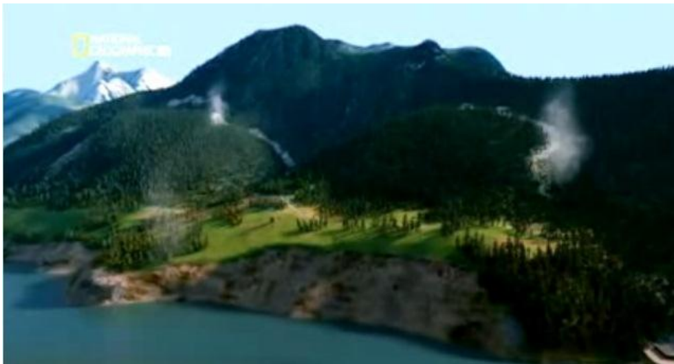
Figura 2.12 Probable inicio del deslizamiento el 9 de Octubre de 1963 (Eatough, 2012)
