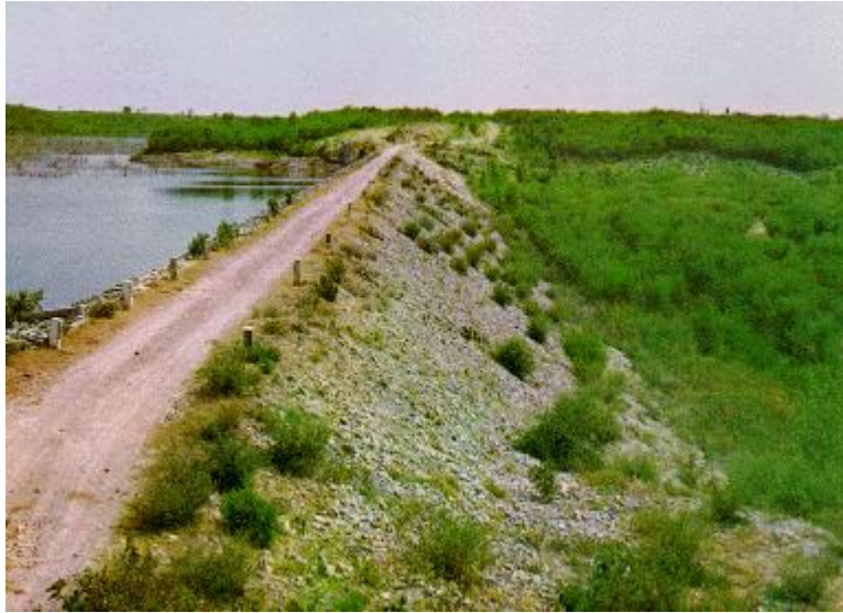
Figura 1.46 Cortina de la Presa La Escondida (Marengo, 2011)
