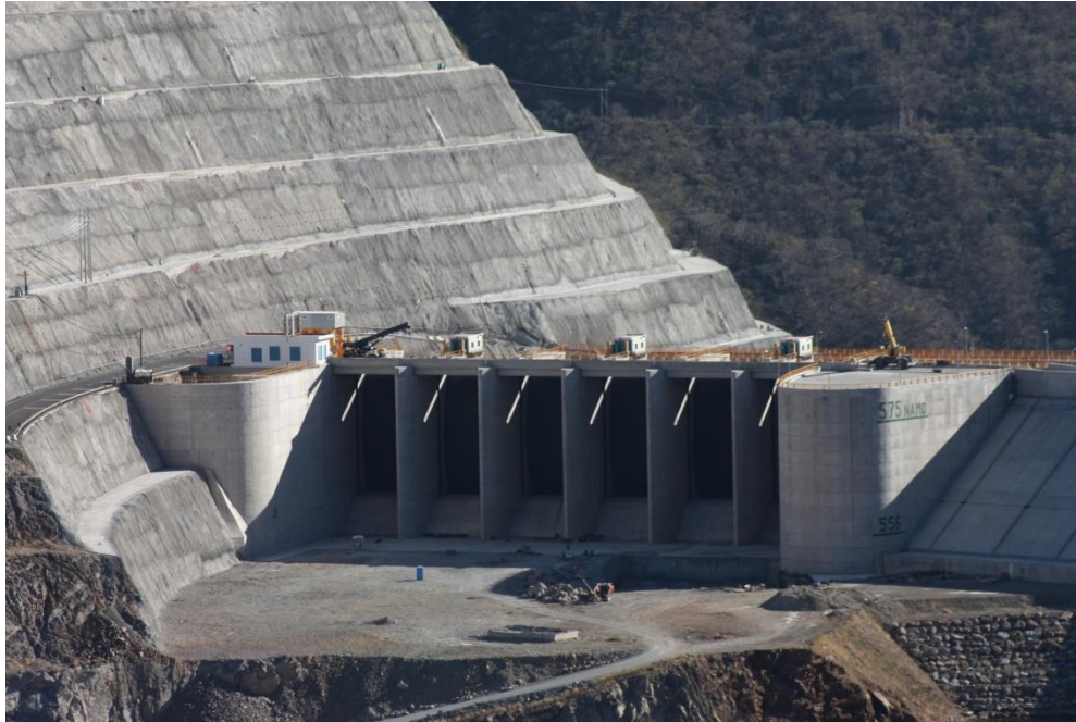
Figura 1.19 Canal de llamada para el vertedor de la C. H. La Yesca. (Fuente Propia)
