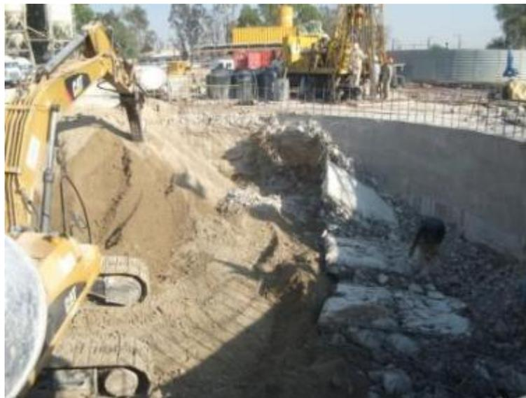
**Fig. 3\_25 Demolición de faldón del brocal interior**
