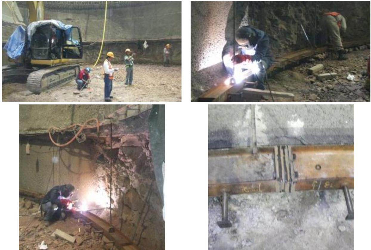
**Fig. 3\_35** Secuencia de colocación de anillo metálico
