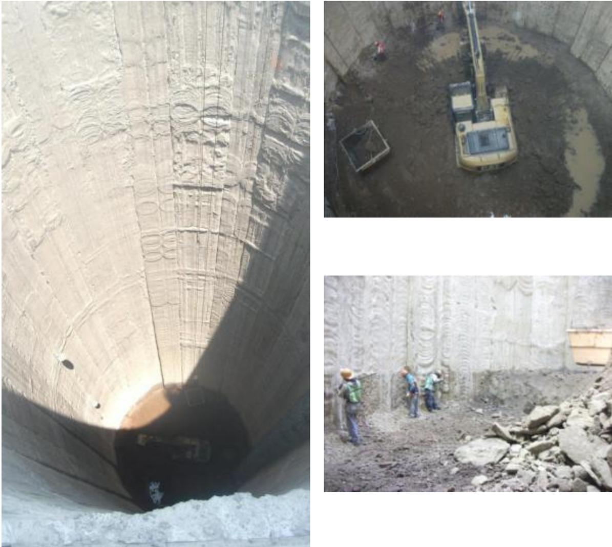
**Fig. 3\_26** Excavación de núcleo y limpieza de tableros.
