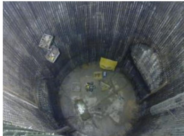
**Fig. 3\_46** Armado de acero paño exterior de revestimiento definitivo en Lumbrera 18
