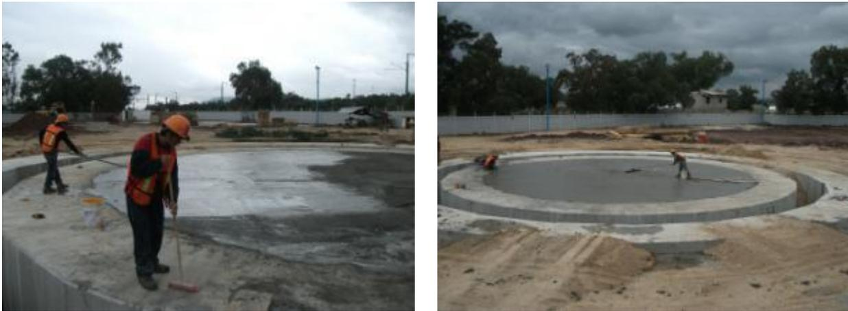
Fig. 3\_6 Secuencia de construcción de losa de servicio (viene de la página anterior).
