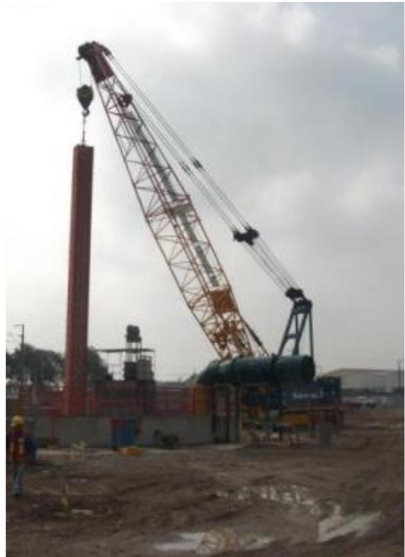
**Fig. 3\_47** Secuencia de montaje de las columnas metálicas (continúa en página siguiente)
