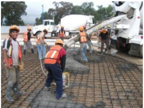
**Fig. 3\_6** Secuencia de construcción de losa de servicio (continúa en la página siguiente).
