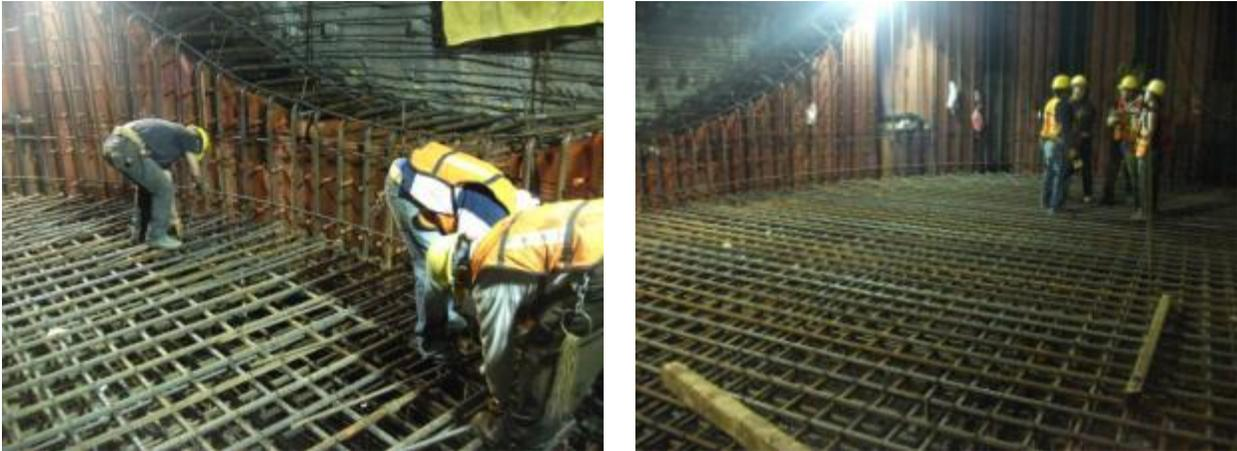
**Fig. 3\_57 Armado de losa de fondo**
