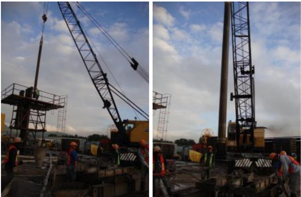
**Fig. 3\_19** Secuencia de colocación de tubería TREMIE (continúa en página siguiente)
