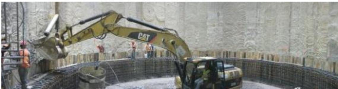
**Fig. 3\_32 Colocación de concreto en la primera etapa de la trabe de liga**
