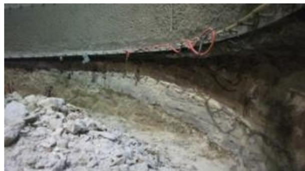
**Fig. 3\_36** Cambio de materiales de excavación en la profundidad aproximada de 83.0 m
