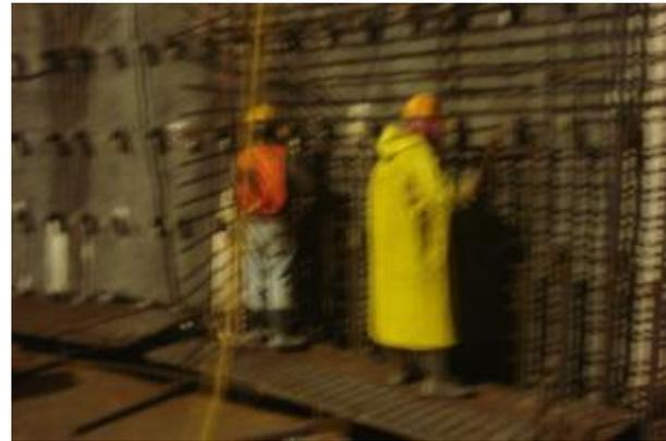
**Fig. 3\_44** Secuencia de maniobras de descenso de plataforma de trabajo y armado de acero en revestimiento definitivo. (viene de la página anterior)
