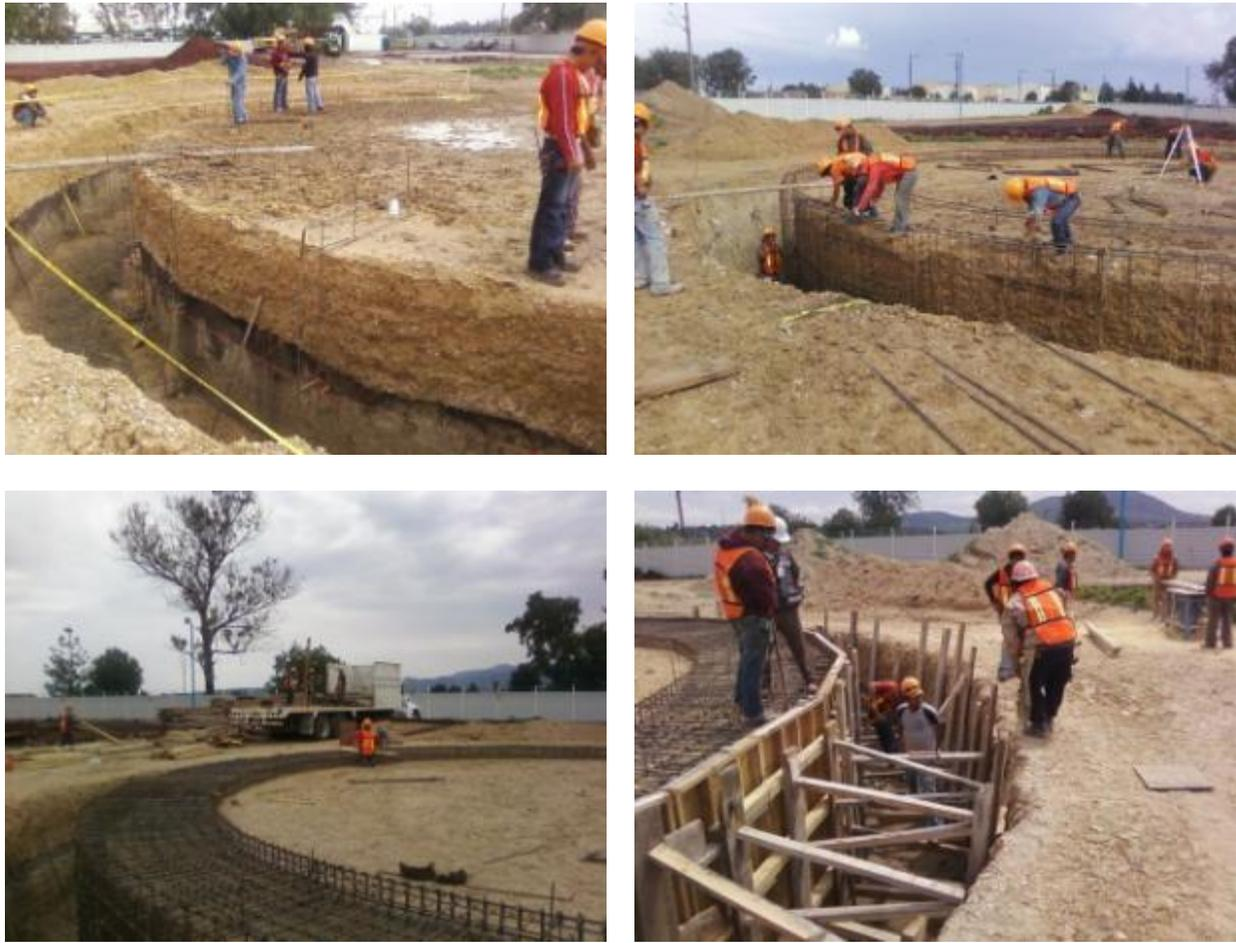
**Fig. 3\_4** Secuencia de armado de acero y cimbra para brocal interior
