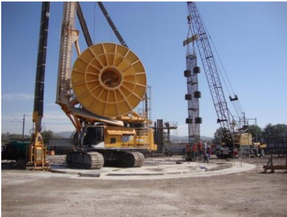
**Fig. 3\_12 Imagen en la que se muestra la excavación de un tablero y la inmersión de acero en el tablero diametralmente opuesto.**
