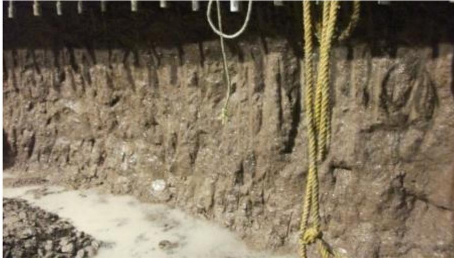
**Fig. 2\_3** Filtración de agua en las paredes de la excavación
