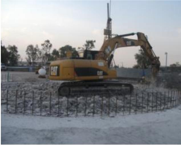
**Fig. 3\_23 Demolición de plataforma de trabajo**
