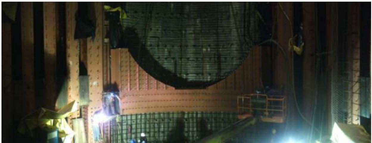
**Fig. 3\_49** Imágenes de montajes de columnas tipo C1 y traves de la estructura metálica. (viene de la página anterior)
