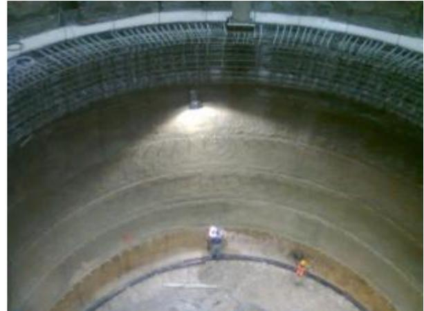
Fig. 3\_38 Secuencia de colocación de concreto lanzado
