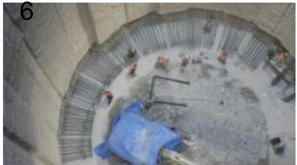
**Fig. 3\_30** Secuencia de armado de trabe de liga: 1.- Escarificado de muro, 2.- Barrenación de muro, 3.- Limpieza de los barrenos con aire comprimido, 4.- Inyección de resina epóxica, 5.- Colocación de acero, 6.- Vista aérea del avance.
