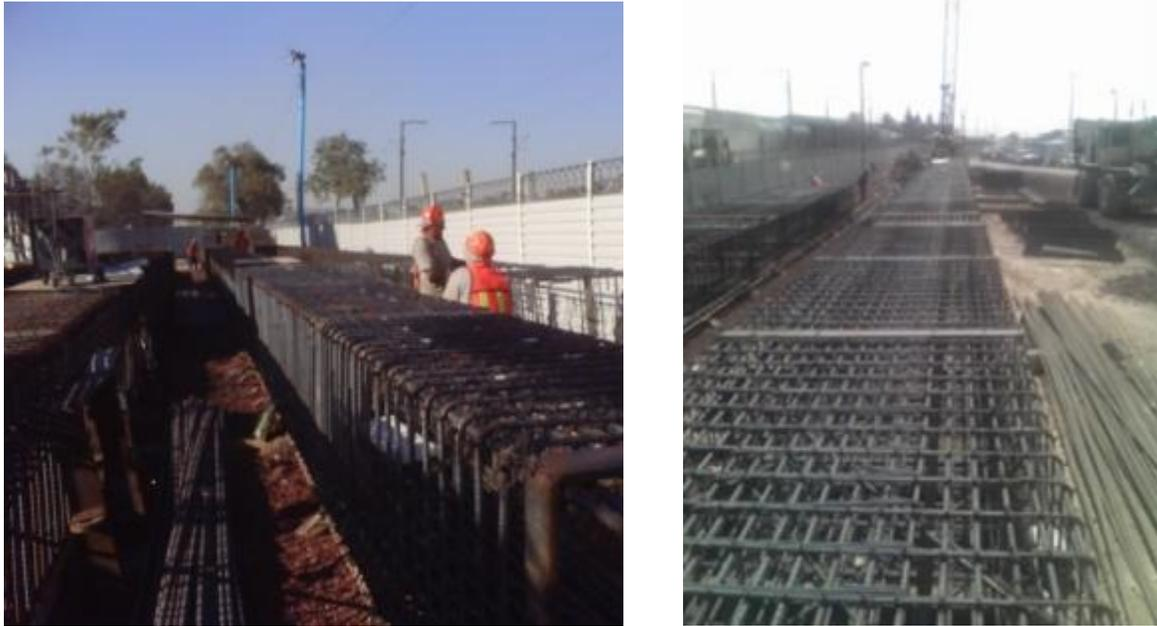
**Fig. 3\_16 Armado del acero de refuerzo para muros Milán**
