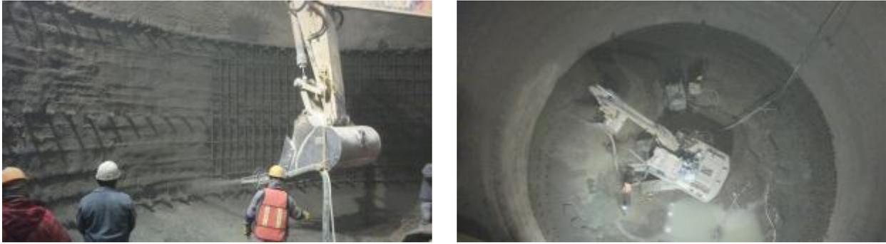
**Fig. 3\_40** Secuencia de construcción de tercera etapa del revestimiento primario.(viene de la página anterior)
