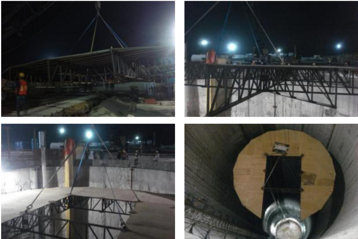
**Fig. 3\_44** Secuencia de maniobras de descenso de plataforma de trabajo y armado de acero en revestimiento definitivo.(continúa en página siguiente).
