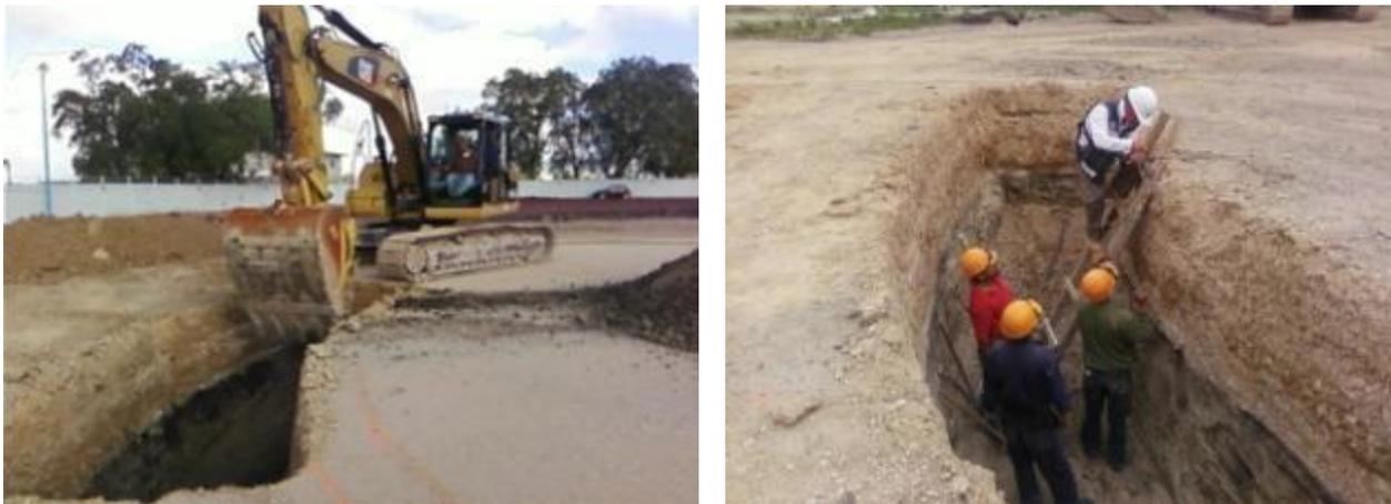
Fig. 3\_3 Excavación de zanja para construcción de brocales interior y exterior
