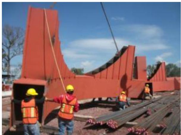
Fig. 3\_48 Imágenes de fabricación en taller y descarga de elementos metálicos en sitio (viene de página anterior)
