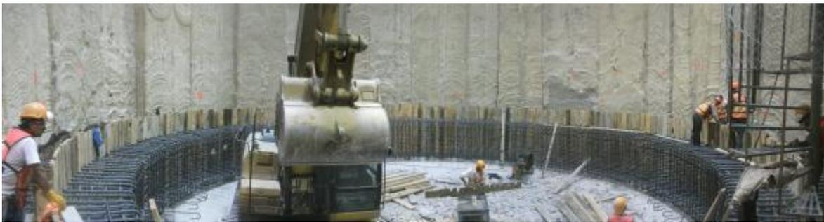
**Fig. 3\_31 Colocación de cimbra de madera en la primera etapa de la trabe de liga.**
