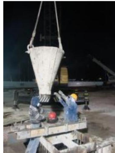
**Fig. 3\_19** Secuencia de colocación de tubería TREMIE (viene de página anterior)
