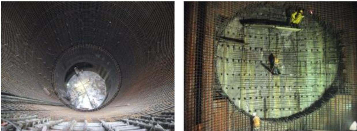
**Fig. 3\_50 Armado de acero terminado en paño interior de revestimiento definitivo**
