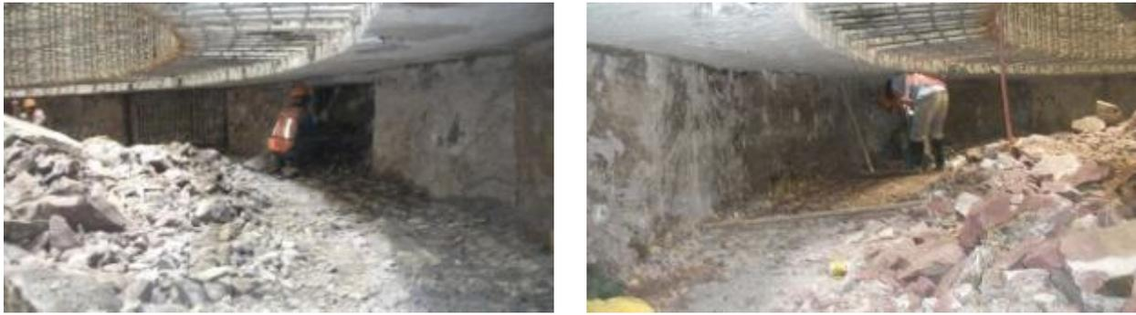
**Fig. 3\_34** Secuencia de excavación y diagrama para 1er y 2° marco metálico (viene de página anterior)
