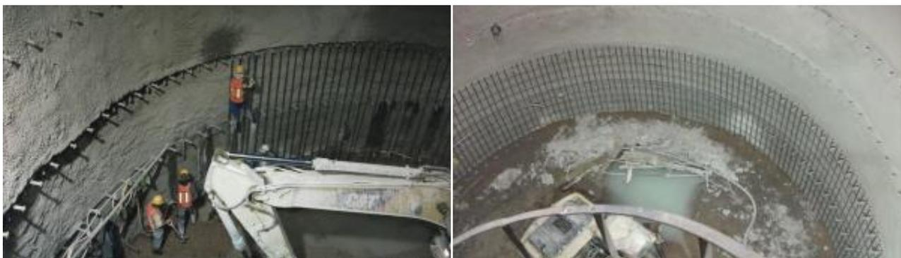
**Fig. 3\_40** Secuencia de construcción de tercera etapa del revestimiento primario (continúa en página siguiente)
