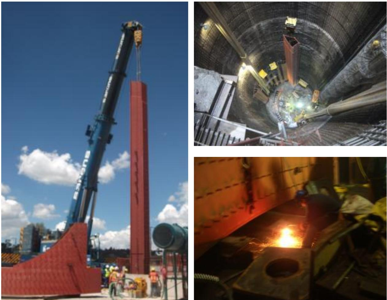
**Fig. 3\_49** Imágenes de montajes de columnas tipo C1 y traveses de la estructura metálica (continúa en la página siguiente)
