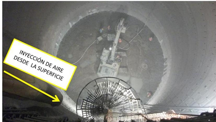
**Fig. 3\_39** Inyección de aire a través de una manga de lona colocada desde la superficie hasta la trabe de liga.
