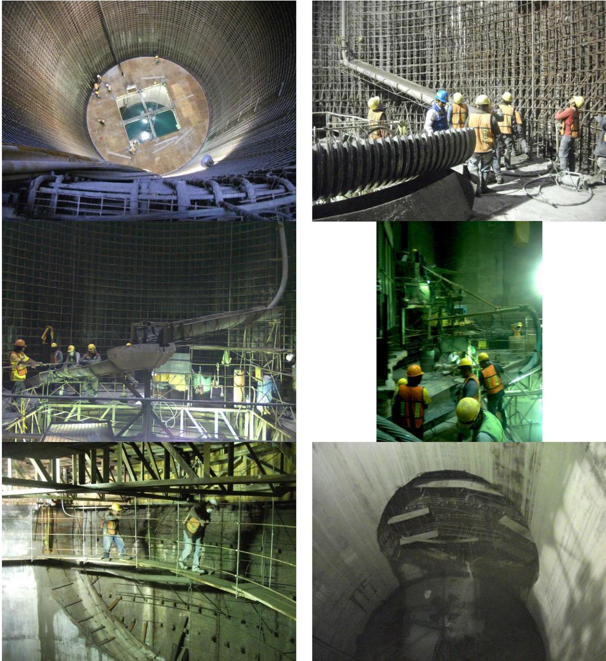
Fig. 3\_52 Secuencia de colocación de concreto en revestimiento definitivo
