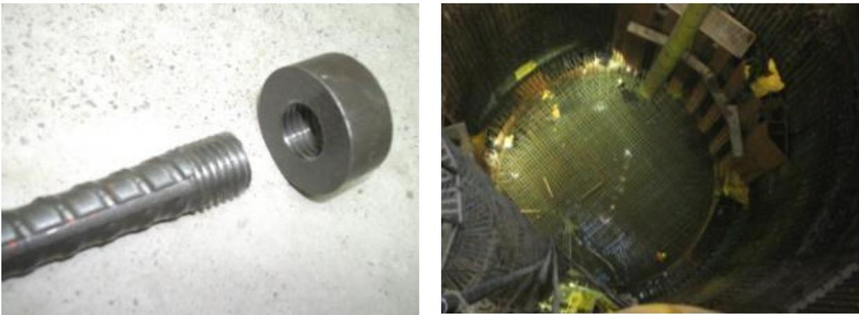
**Fig. 3\_58 Conectores tipo “Lenton terminator” y armado de losa de fondo terminado**
