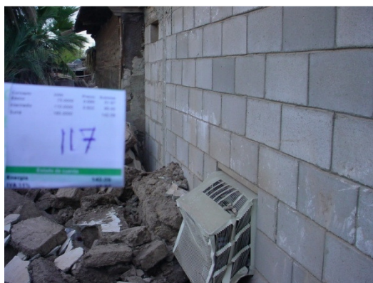
Figura 4.7 Vivienda conformada con block en los muros
