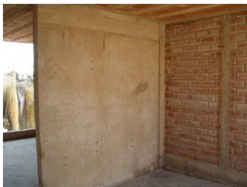
Figura 3.16 Vivienda con concreto como material de muro
