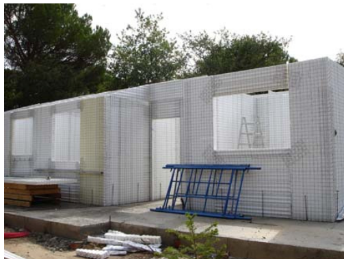
Figura 3.10 Vivienda con panel como material de construcción
