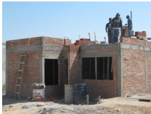
Figura 3.13 Vivienda con tabique como material de muro
