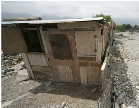
Figura 3.6 Vivienda con madera como material de construcción
