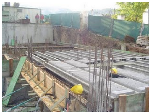
Figura 3.19 Vivienda con vigueta como material de techo
