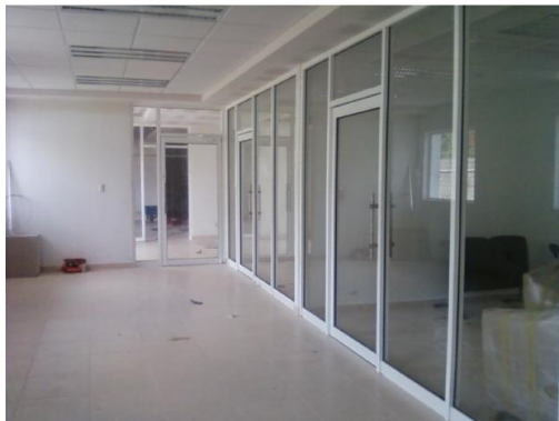
Figura 3.11 Vivienda con vidrio como material de muro
