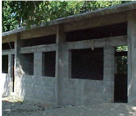
Figura 3.14 Vivienda con block como material de muro
