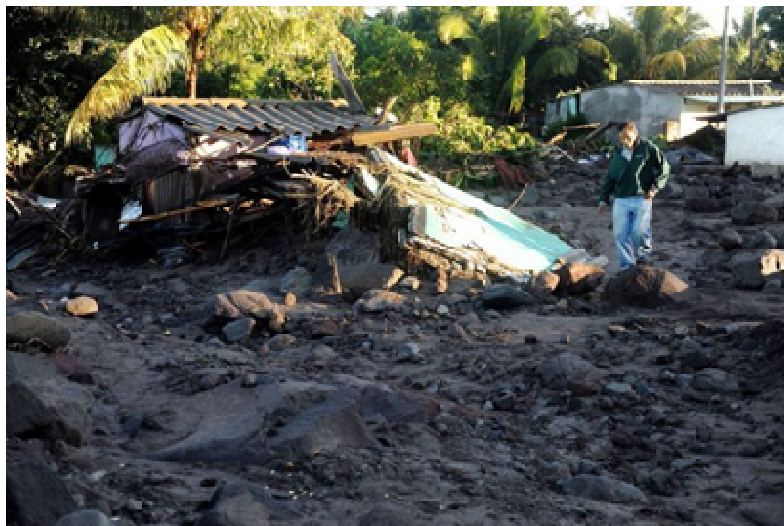
Figura B7. Ejemplo de una vivienda con azolve mayor de dos metros de altura
