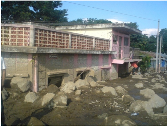
Figura B6. Ejemplo de una vivienda con azolve mayor a un metro y menor de dos metros de altura
