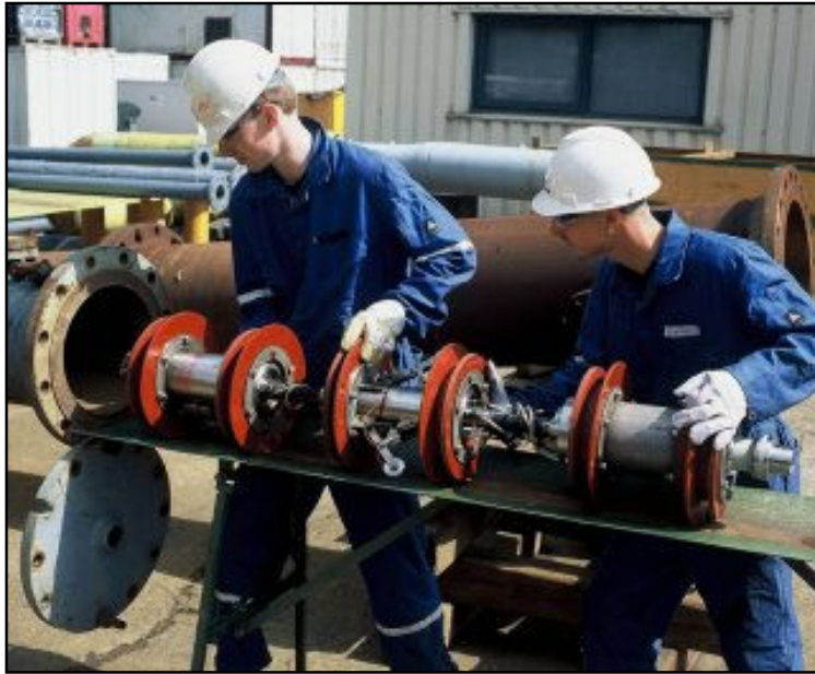
Figura 1.19. Introducción del Pig a la Línea de Esgurrimiento.
