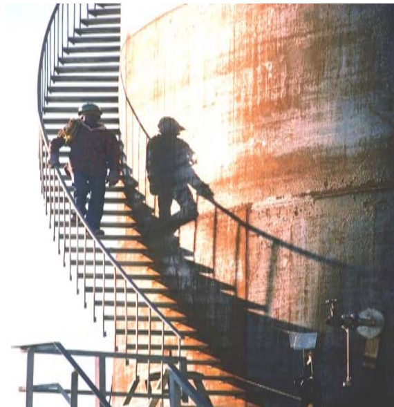
Figura 3.11 Escaleras en el exterior del tanque
