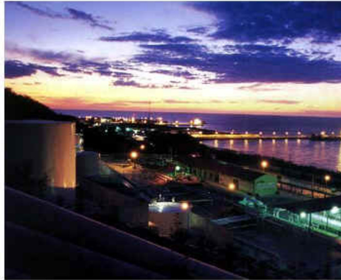
Figura 3.11 Terminal de almacenamiento y distribución en Campeche
