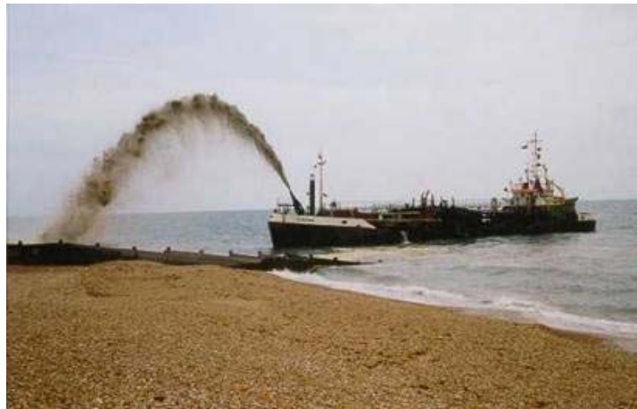
Figura 2. 3 Relleno de playa por bombeo de arena
