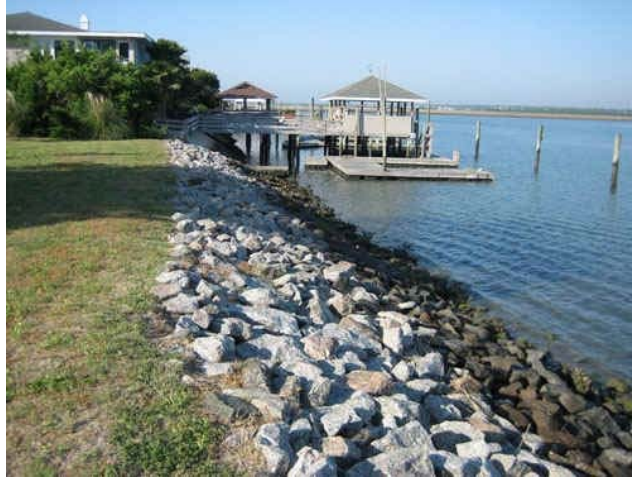
Figura 2. 12 Revestimiento de playa, utilizando material rocoso
