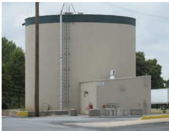
**Figura 5.9 TANQUE DE ALMACENAMIENTO DE AGUA CONTRAINCENDIO**
