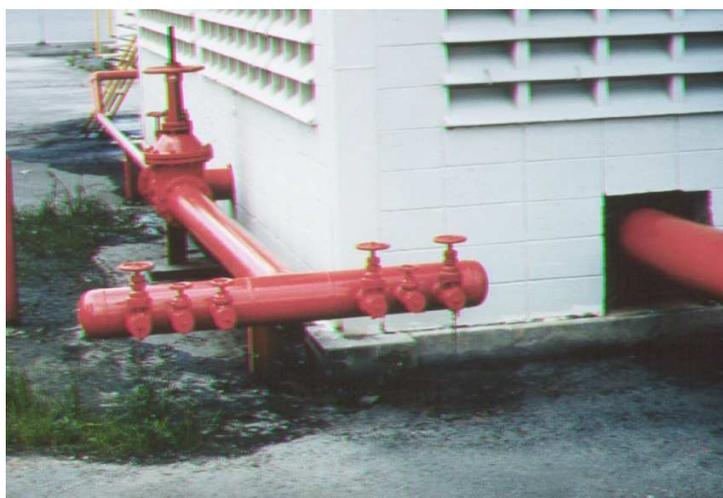
**Figura 5.16 CABEZAL DE PRUEBAS**
