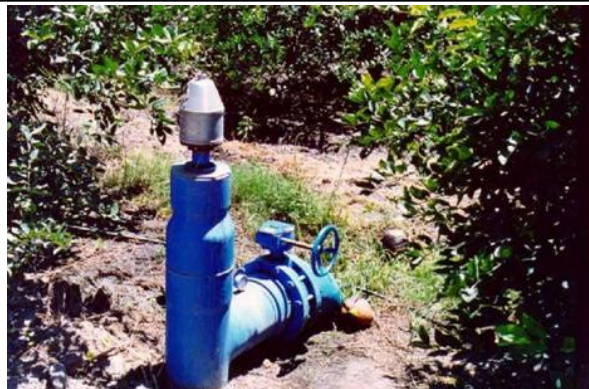
Fig. 40. Válvula de admisión y expulsión de aire, junto a una válvula de
