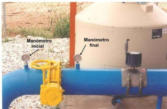
Tubería de descarga; cuando la planta de bombeo tiene varias unidades de bombeo cada una de ellas puede descargar individualmente. Sin embargo, por razones económicas, es común conectar cada tubería de descarga a una de mayor diámetro. Si la bomba descarga a una tubería de gran longitud su diámetro debe ser mayor que la descarga de la bomba, para reducir las pérdidas de energía por fricción.
