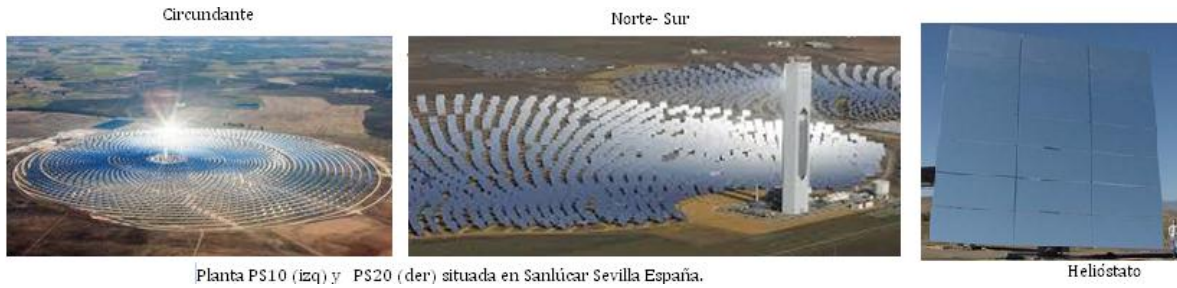
Figura 1. 15 Despliegue de un campo de heliostatos alrededor de un receptor central. 16
