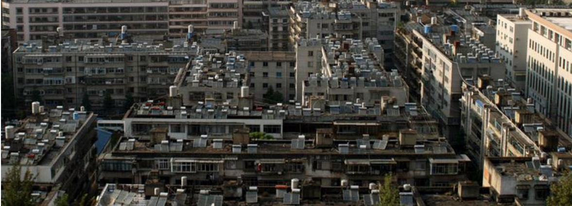
Figura 1.7 Casas chinas con colectores solares planos. 6
