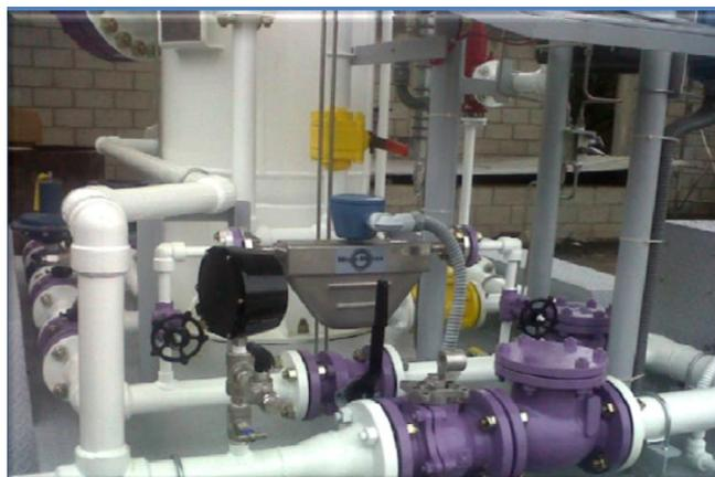
**Figura I.3 Medidor tipo Coriolis instalado en una batería de separación.**
