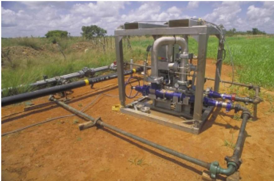
**Figura II.24 Medidor Vortex instalado en una línea de descarga.**
