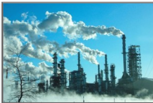
Figura 19. Planta Termoeléctrica. Fuente: http://radio.uchile.cl/noticias/80444/ .
