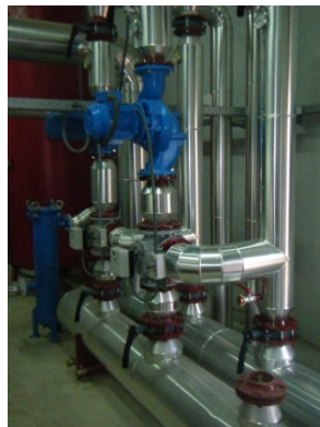
Fig.11.- Calefacción en un invernadero mediante tuberías.
