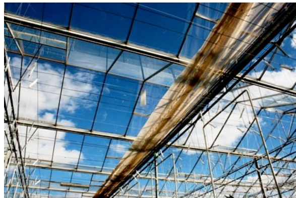
Fig.8.-Estructura de un invernadero holandés.
