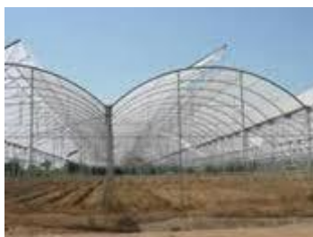
Fig.35.- Estructura de invernadero tipo túnel.
