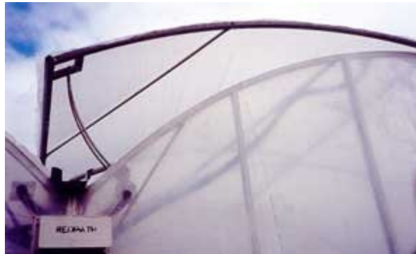
Fig.13.-Apertura automática de la ventilación en invernaderos
