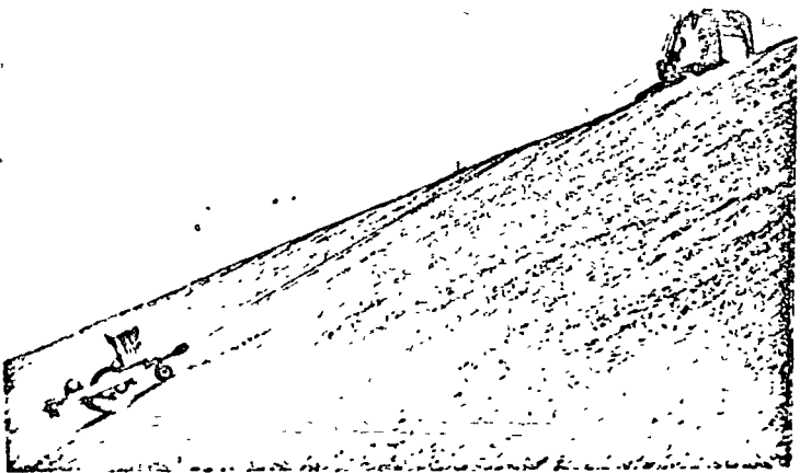
FIG. II.XIX — Rodillo remolcado vibrante para compactación de taludes de canales; pesos: 4,2 t. Ancho de compactación: 1,65 m. (Foto Richer.)
