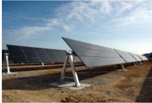
Figura 5: Sistema de seguimiento horizontal
