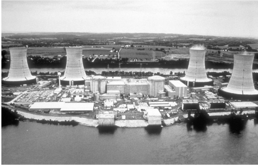
Figura N° 5.1 Planta nucleoelectrica en la Isla de Tres Millas, estación TMI-1 [izq] y TMI-2 [der] [8].
