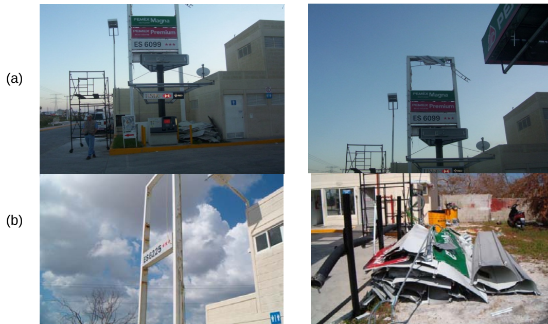
Figura 2.33 Daños en los espectaculares gasolinera 3G(a) y 15G(b)
