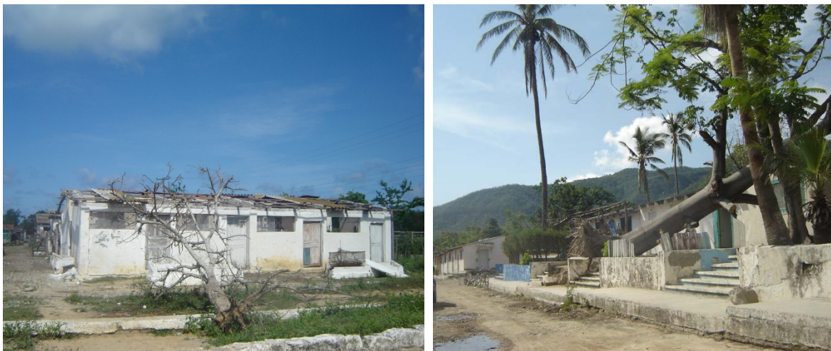
Figura 2.21 Desprendimiento de arboles por acción del viento
