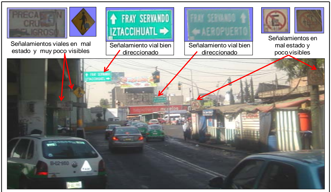
Fotografía 5. Lateral de Circuito Interior dirección al Eje 3 Oriente, al entronque con Ignacio Zaragoza.
