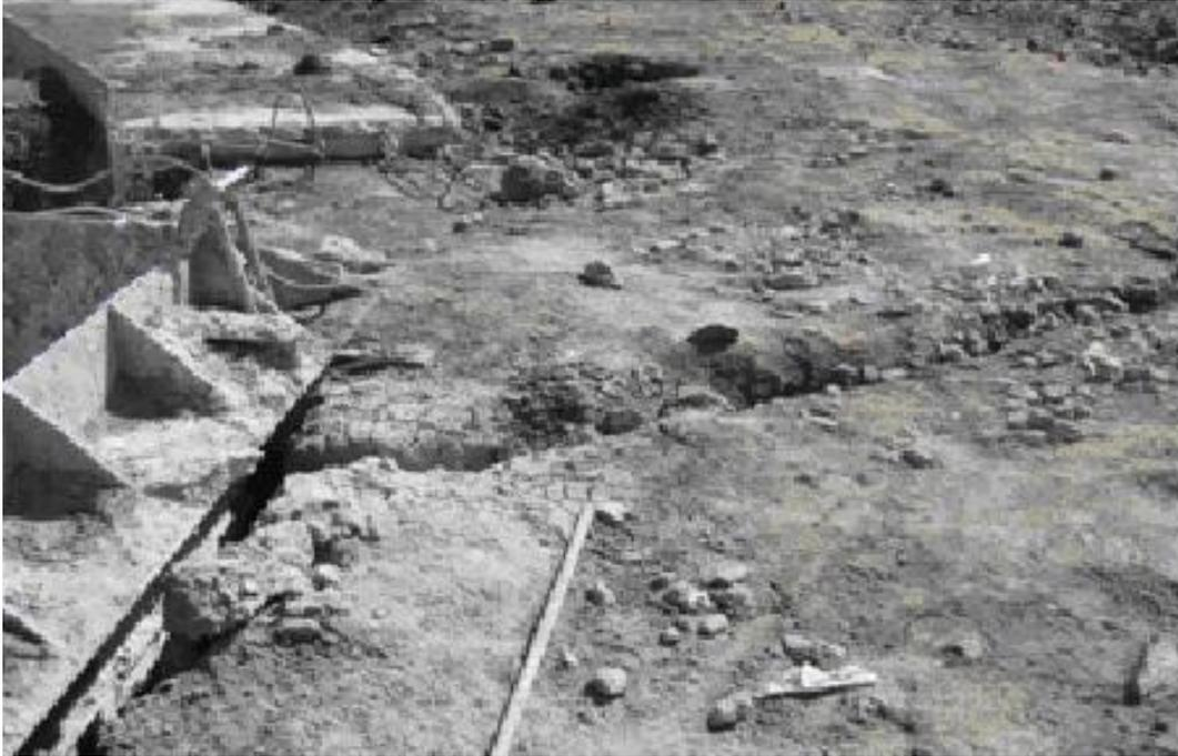
**Figura 3.10** Agrietamiento inducido por la presión de lodo autofraguante en un panel de una pared colocada in situ (Lumbrera 3, Túnel Río de los Remedios).
