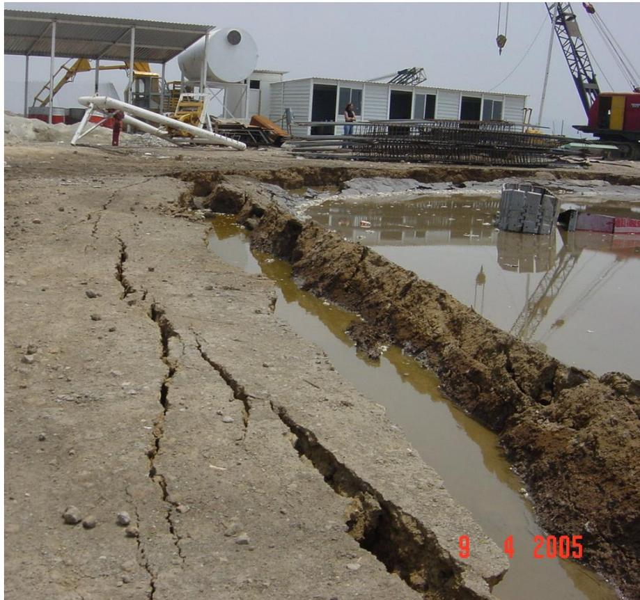
**Figura 3.20** Falla lumbrera L6 del Túnel del Río de los Remedios
