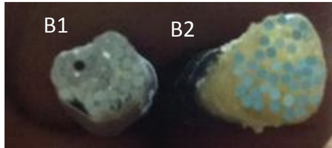
Figura 4.9. Bundle 1 (B1) y Bundle 2 (B2) de F.O. Vista de un extremo.
