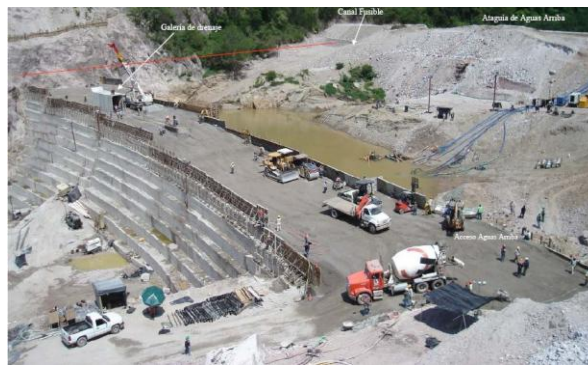
Fig. 6.1 Construcción de la presa Picachus
