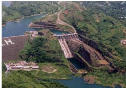
Fig. 1. Presa de enrocamiento y tierra, Hidroeléctrica Malpaso
