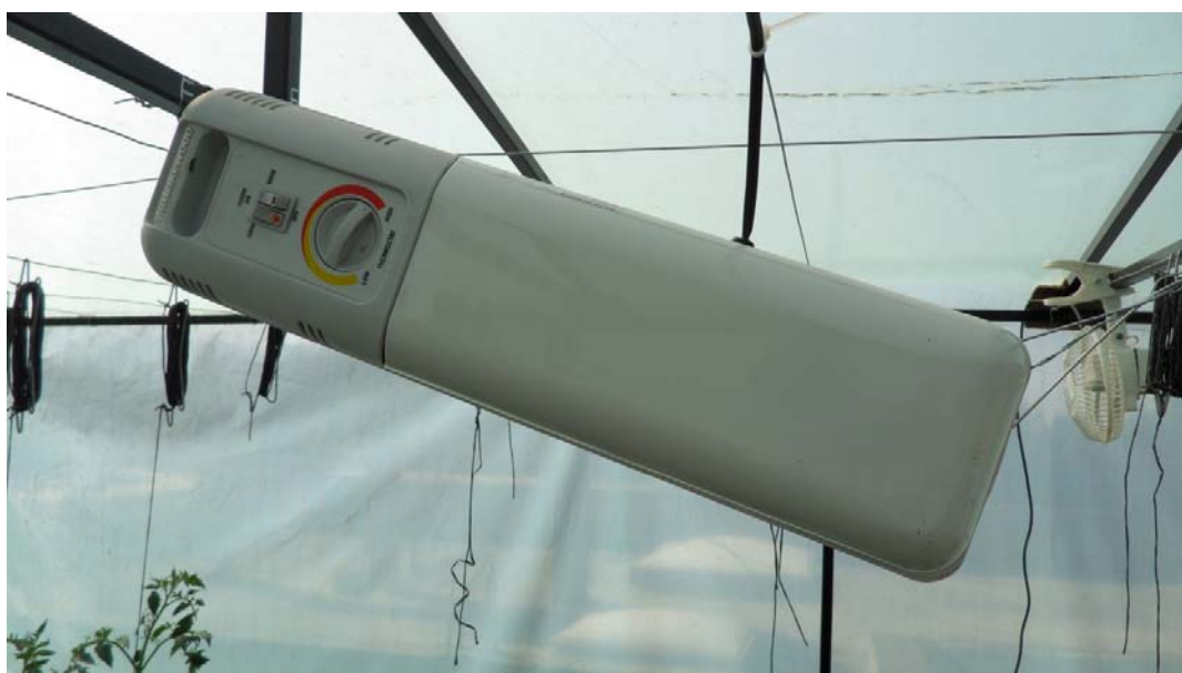
Figura 3.5: Resistencia 110 Vca, 1000 W.
