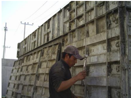
FOTO 1.- ARMADO DEL MOLDE (1RA VEZ DEL DIA).
