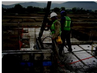
FOTO 5.- COLADO DEL MOLDE (2DA VEZ DEL DIA).
