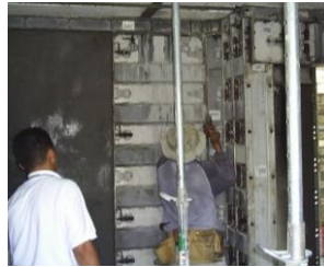
FOTO 6 . - RETIRO DE CIMBRA DE EL MOLDE DESPUÉS DEL SEGUNDO COLADO.
