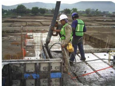
FOTO 2.- COLADO DEL MOLDE (1RA VEZ DEL DIA).
