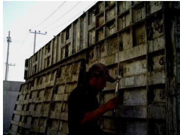
FOTO 4.- ARMADO DEL MOLDE (2DA VEZ DEL DIA).
