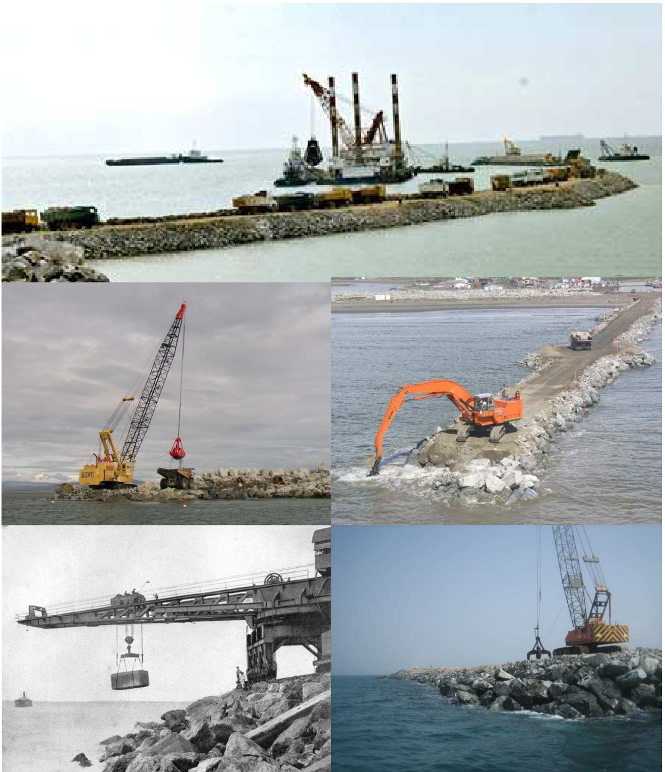
Figura 3.12 Equipo de Construcción Utilizado en un Rompeolas en Talud
