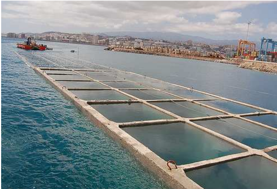
Figura 3.10 Colocación y Relleno de Cajones en el Puerto de Las Palmas
