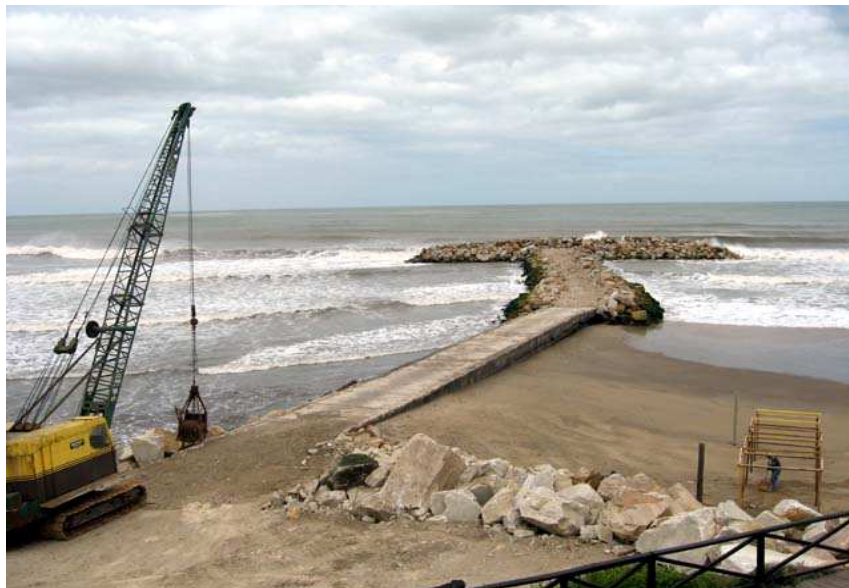
Figura 3.11 Construcción de un Rompeolas en Talud
