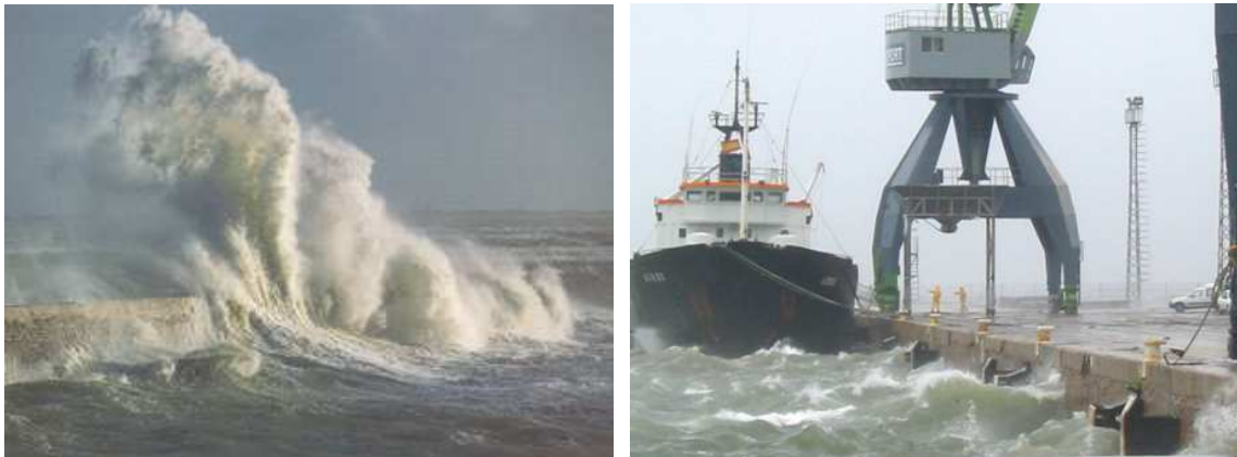
Figura 4.10 Limitación de la Operación en Puerto por Rebase
