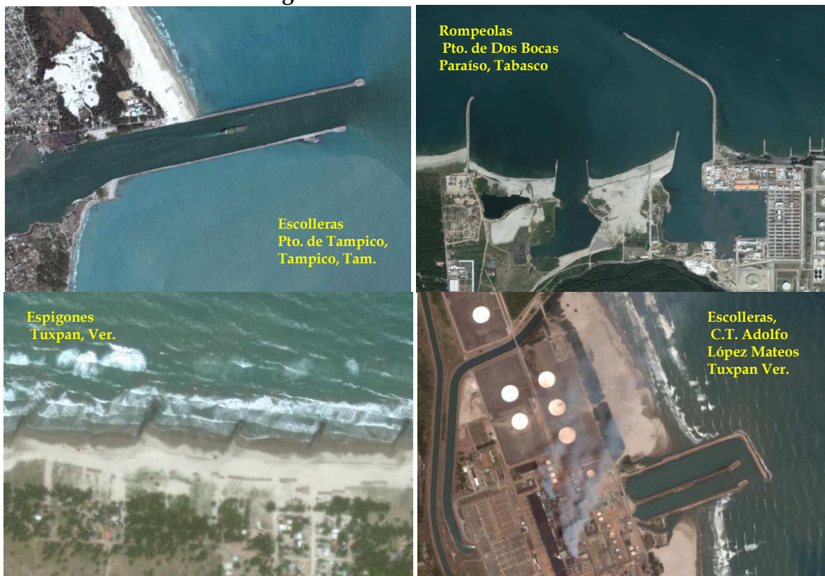
Figura 3.2 Obras de Protección
