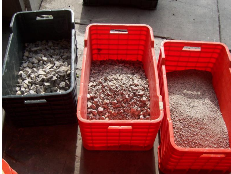
Figura 3.11. Material utilizado para la construcción del humedal
