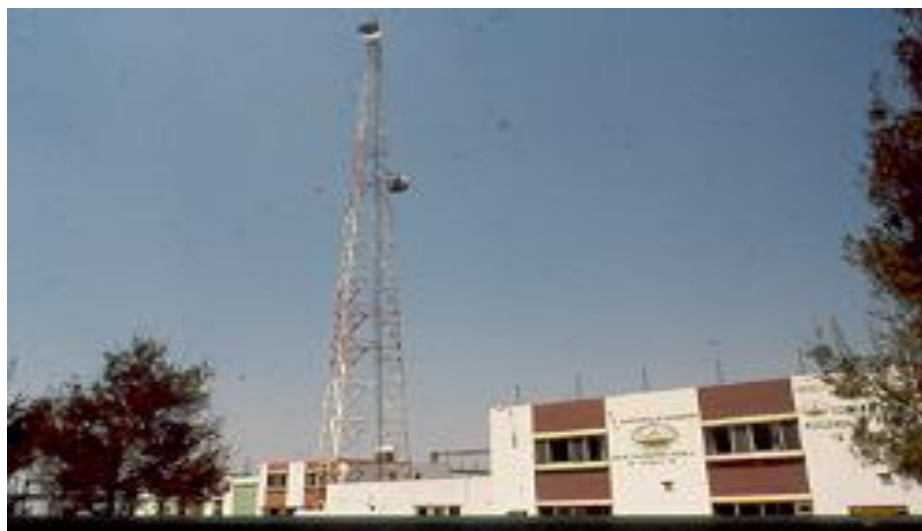
Figura 4.2.2 Sistema de Teleprotección por Microondas
