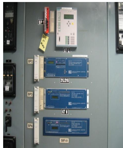
Figura 3.2.2 Esquema de protección digital 85L, 21/21N, 67N, 50FI.
