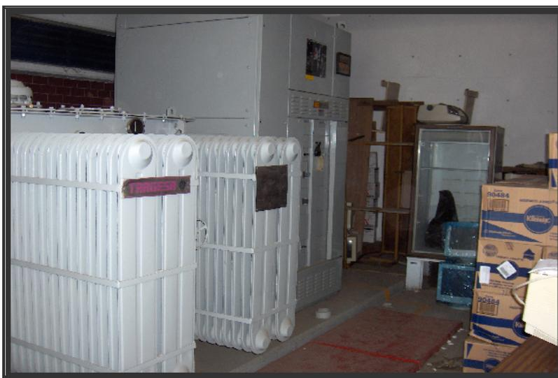
**Figura No. 3.1. Subestación Derivada utilizada como bodega.**
