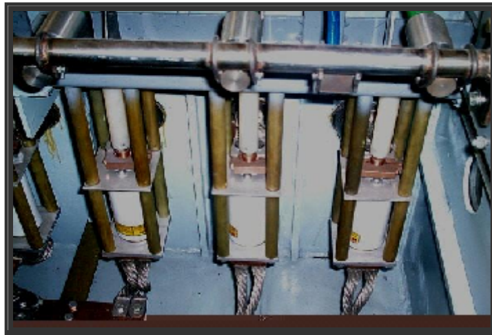
Figura No. 2.9. Cámaras de interrupción en vacío.
