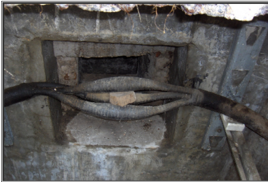
Figura C. Cable tripolar con aislamiento de papel impregnado en aceite.
