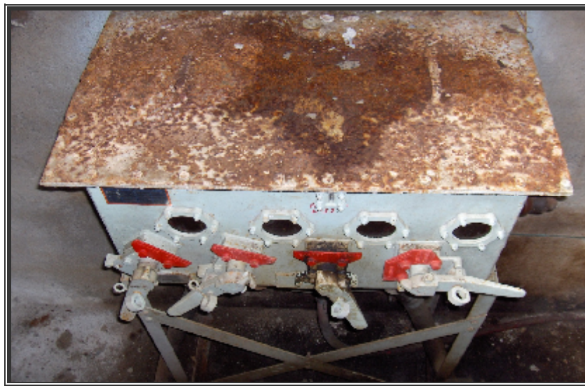
Figura D. Seccionador trifásico de 3 vías con aislamiento en aceite mineral.
