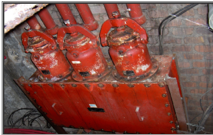
Figura E. Interruptores en pequeño volumen de aceite (Trompos).
