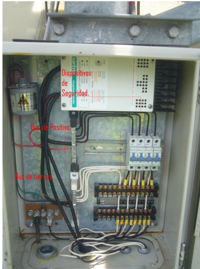
Figura 2.9 Caja de paralelos con sus respectivos componentes.
