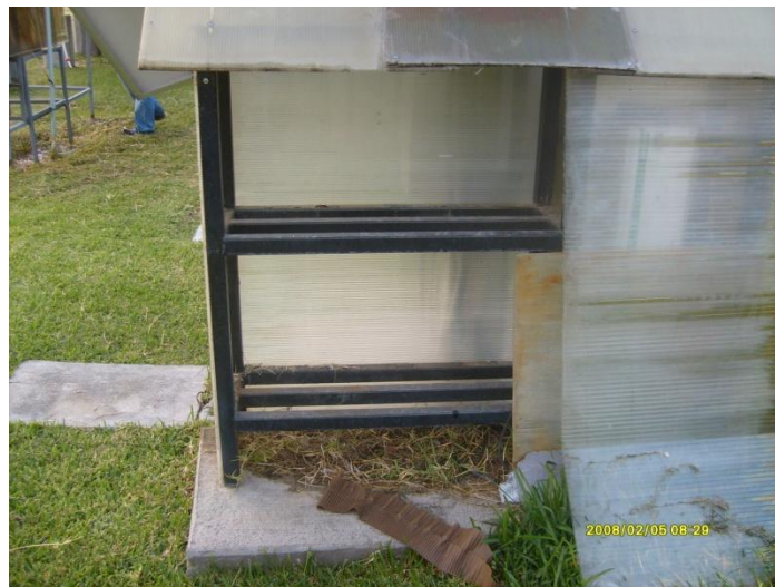
Figura 2.23 Caseta para montar el banco de baterías.
