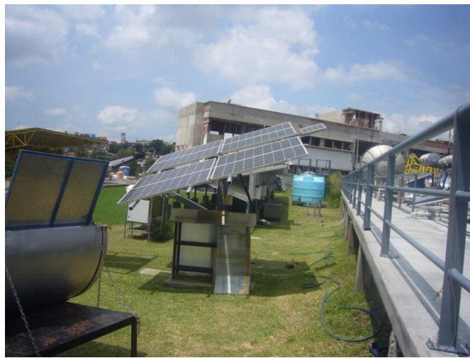
Figura 2.21 Lugar libre de sombras del panel fotovoltaico.
