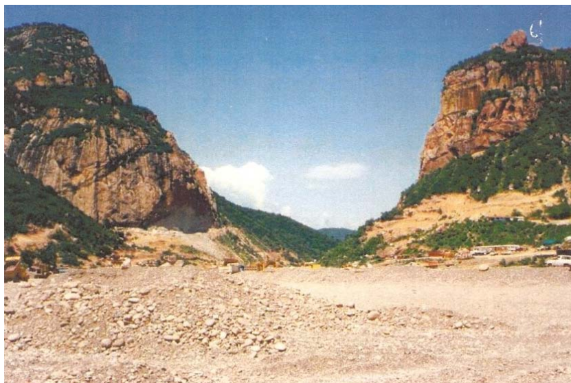
Figura 86. Presa “Huites”, vista del sitio desde aguas abajo antes del inicio de la obra (Hungsberg, 2001).
