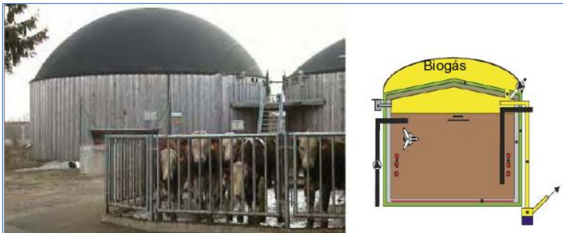
Figura 2.5 Digestor completamente mezclado (Ostrem, 2004)
